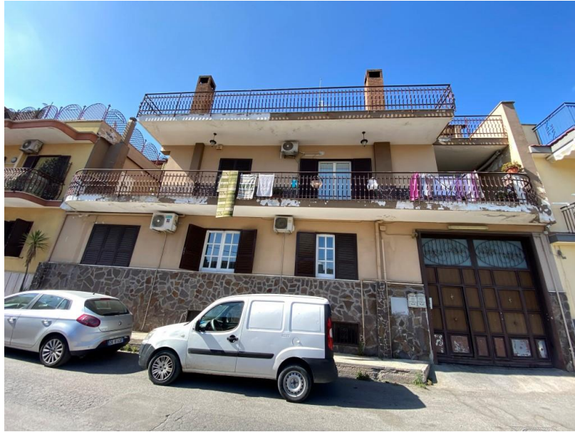
Esterno lato sud
