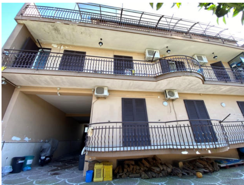
Esterno lato nord
