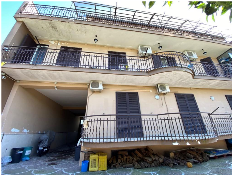
Esterno lato nord
