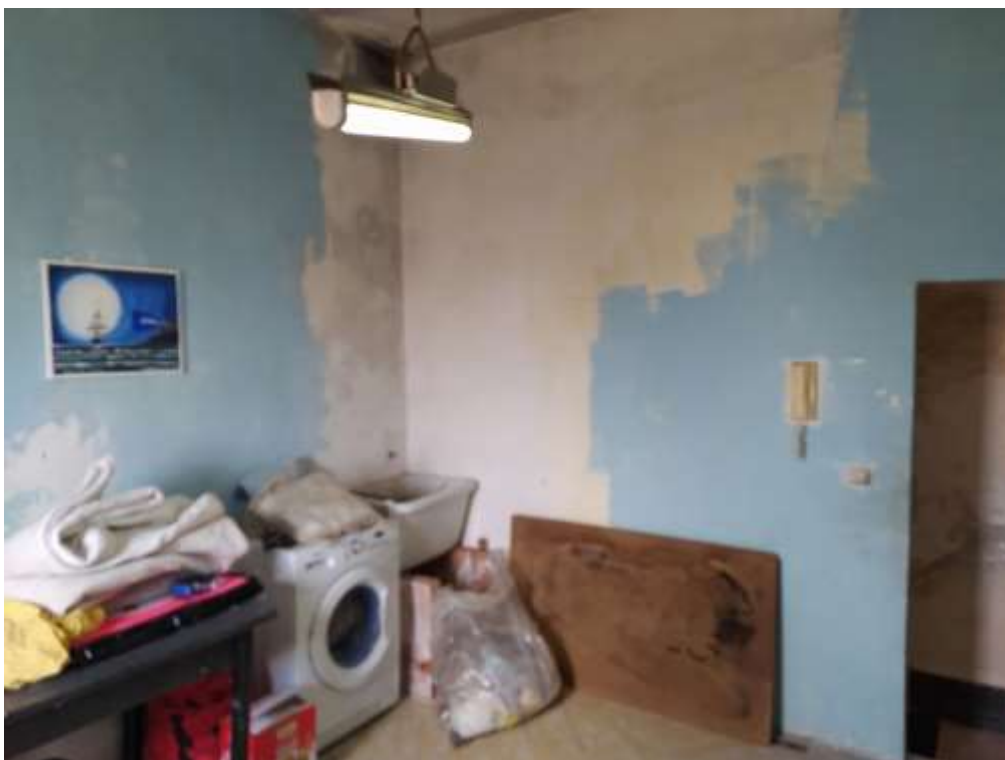
Fot. 12: vano, piano secondo
