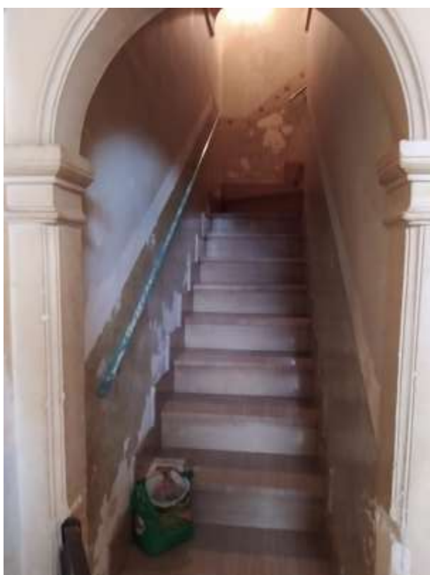
Fot. 6: vano scala che conduce al piano primo
