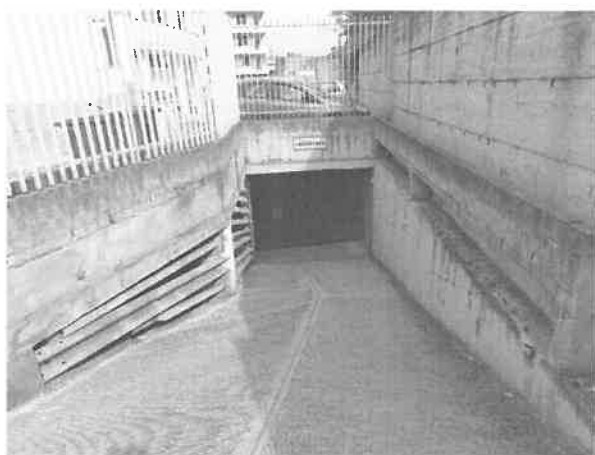
Ingresso dall'esterno al sub 47
