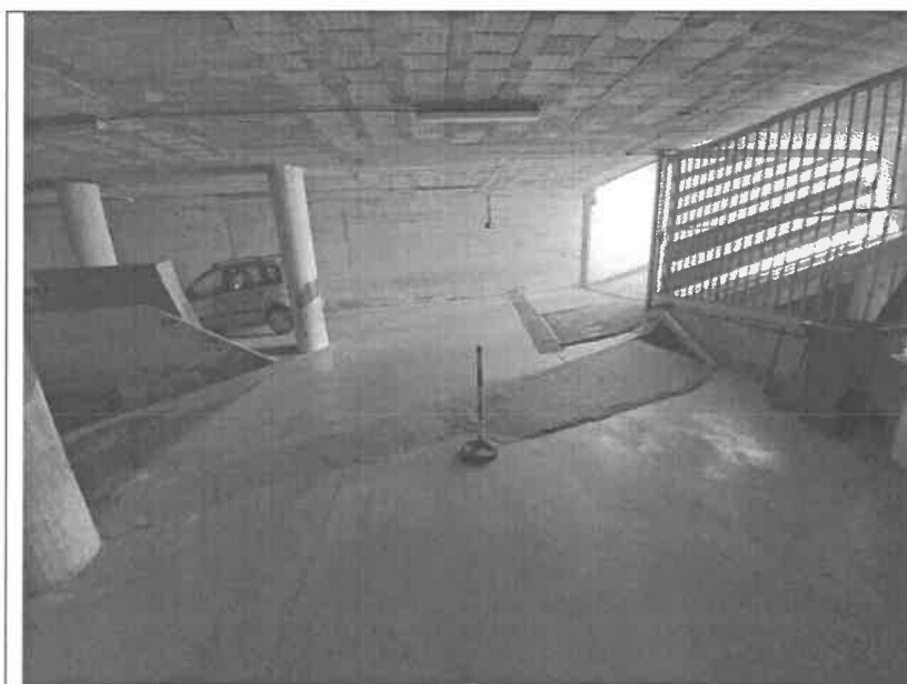
Rampa del sub 49
