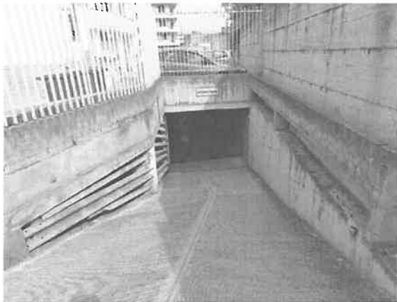
Ingresso dall'esterno al sub 47
