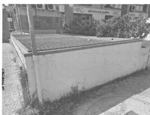
Foto 33 - Arrivo del "pozzo d'aria" sul cortile
