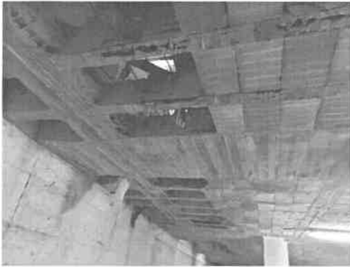
Foto 35 – Le "prese d'aria" sul soffitto
