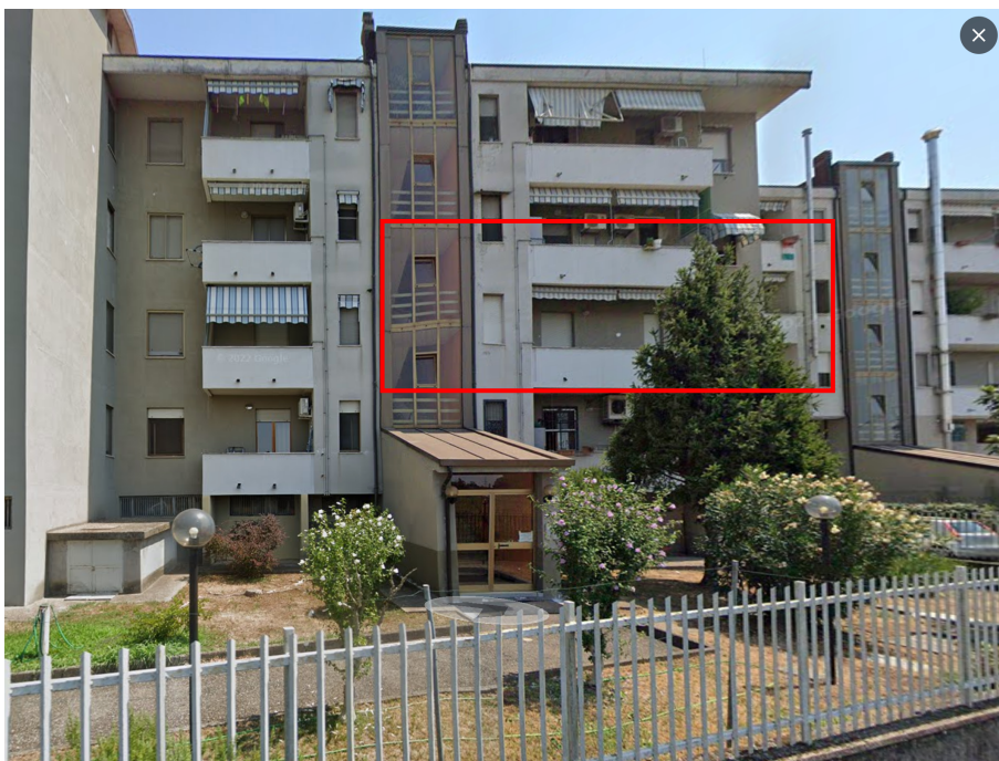
Immagine 1. Il fabbricato nel contesto urbano. Dato che attualmente è presente un ponteggio sulle facciate, la foto è presa da Google maps.
