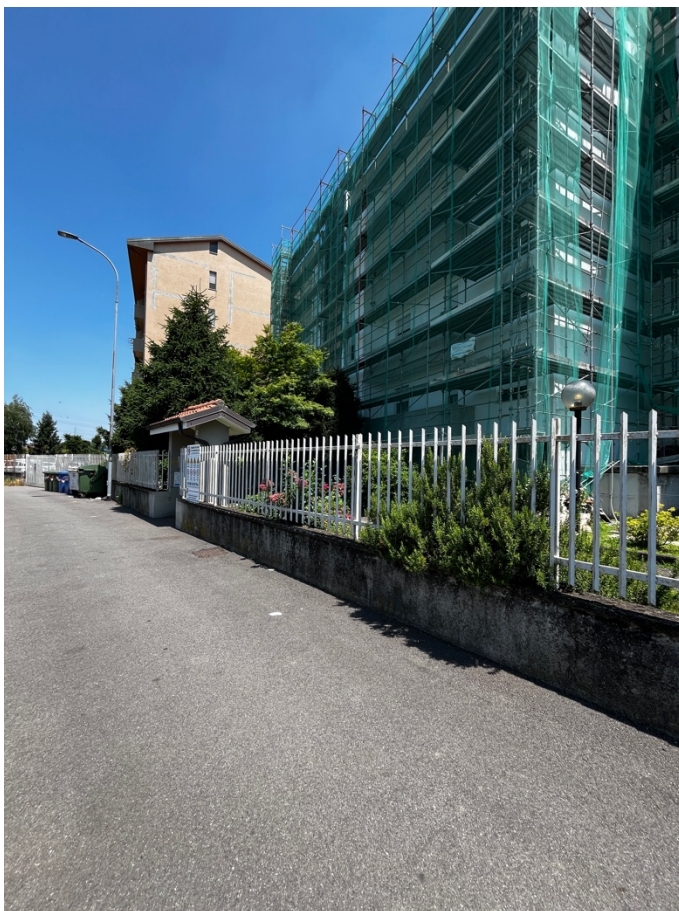
Immagine 2. Il fabbricato. Fronte di accesso con il ponteggio per i lavori di efficientamento energetico (cosiddetto 110%); i lavori sono in corso, sebbene avessero previsione di ultimazione nel 2023.
