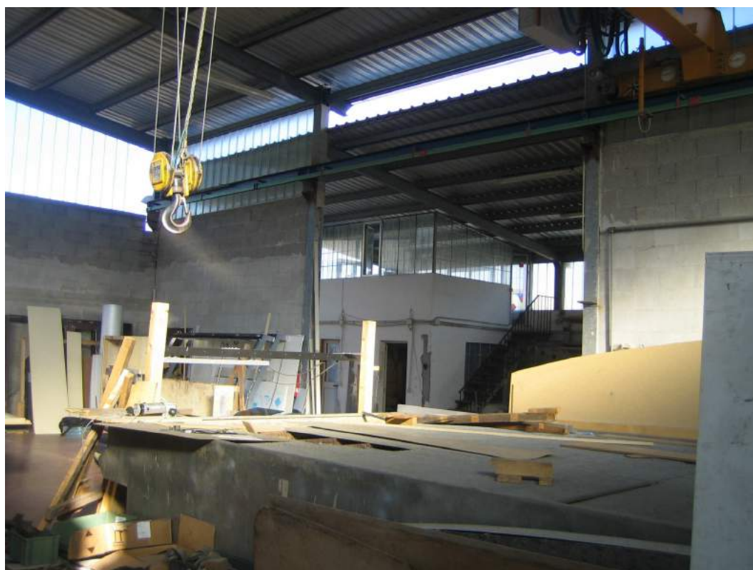
LOTTO 1 - foto n. 12 - Panoramica interna
