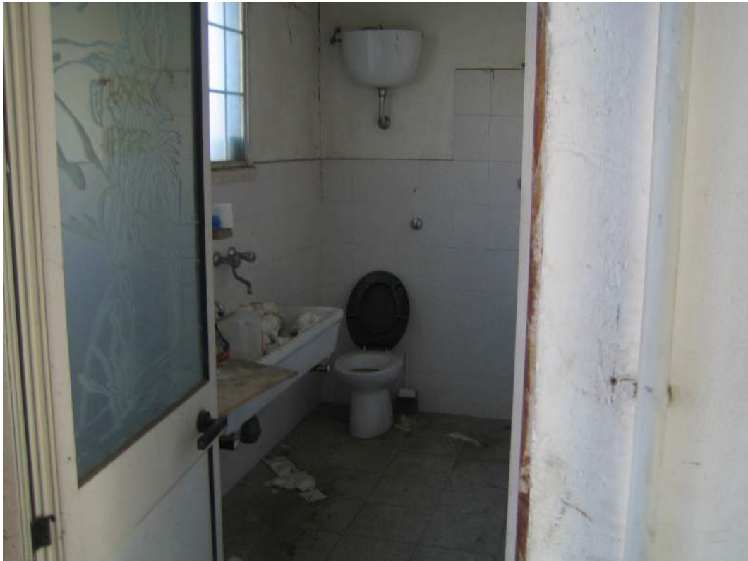
LOTTO 1 - foto n. 13 - Panoramica interna
