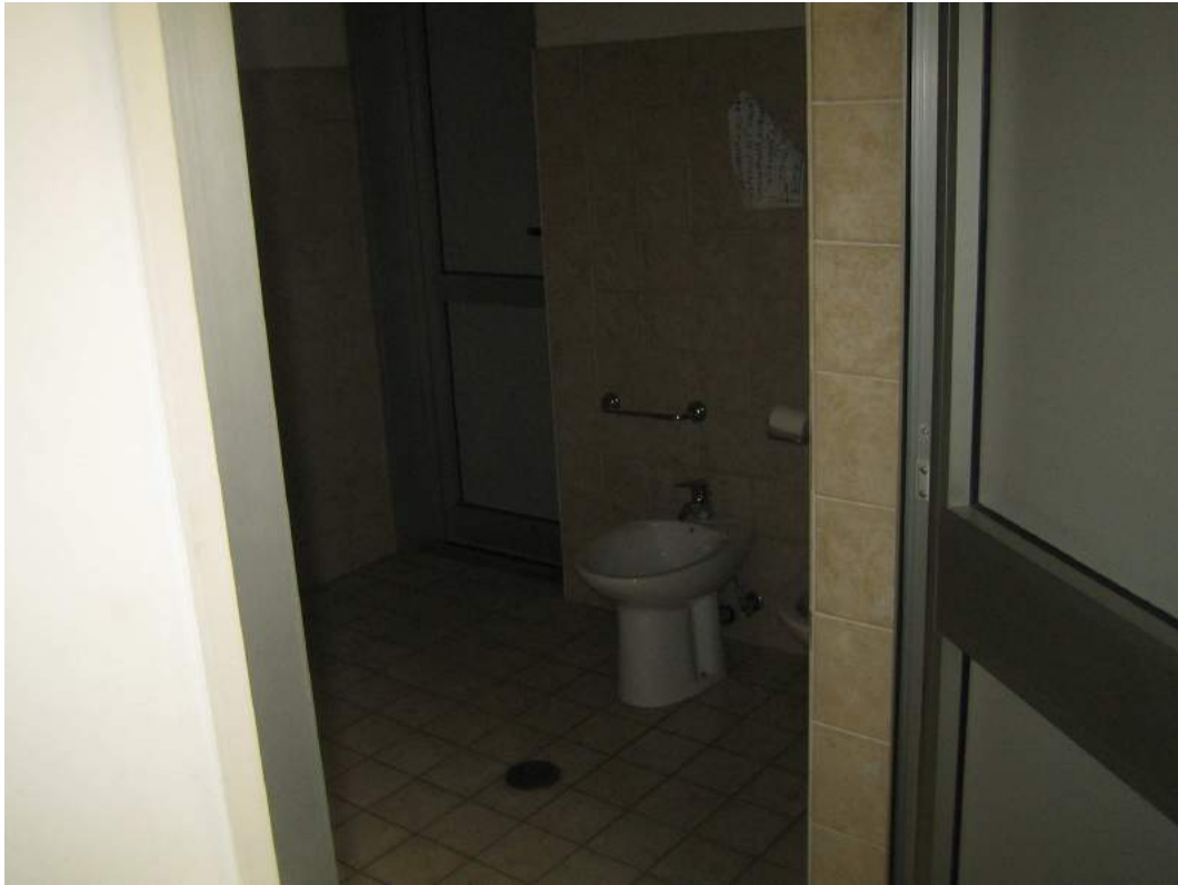
LOTTO 2 - foto n. 24 - Panoramica interna - Piano primo
