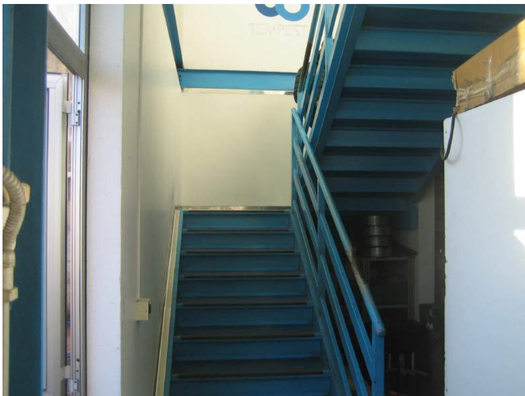
LOTTO 2 - foto n. 19 - Panoramica interna
