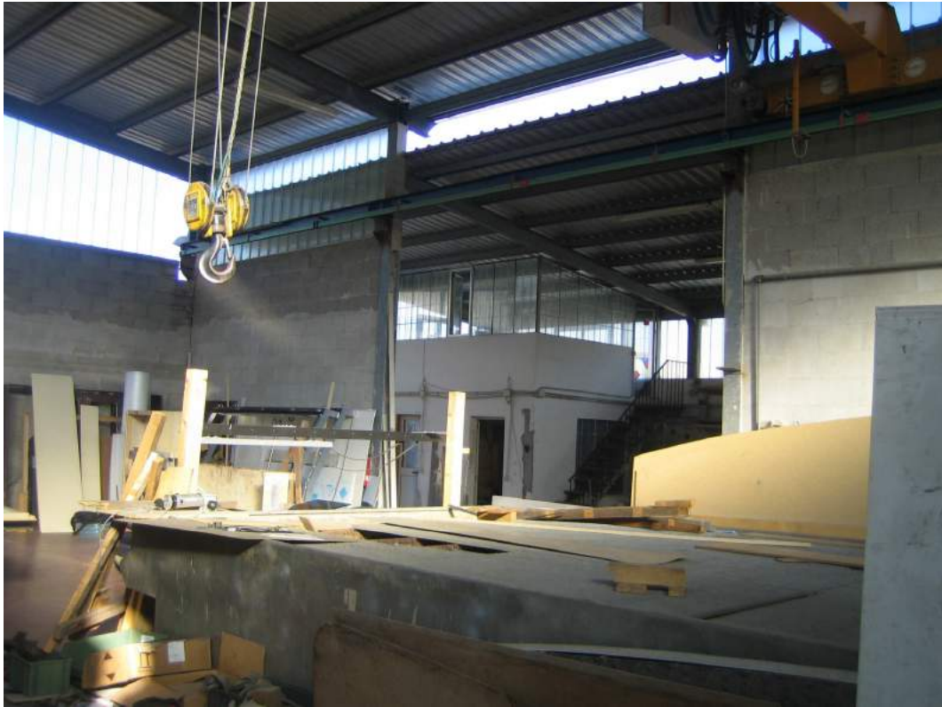
LOTTO 1 - foto n. 7 - Panoramica interna
