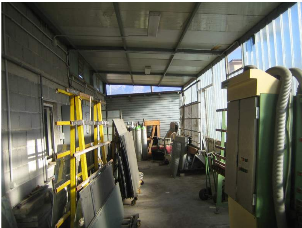
LOTTO 1 - foto n. 15 - Panoramica interna
