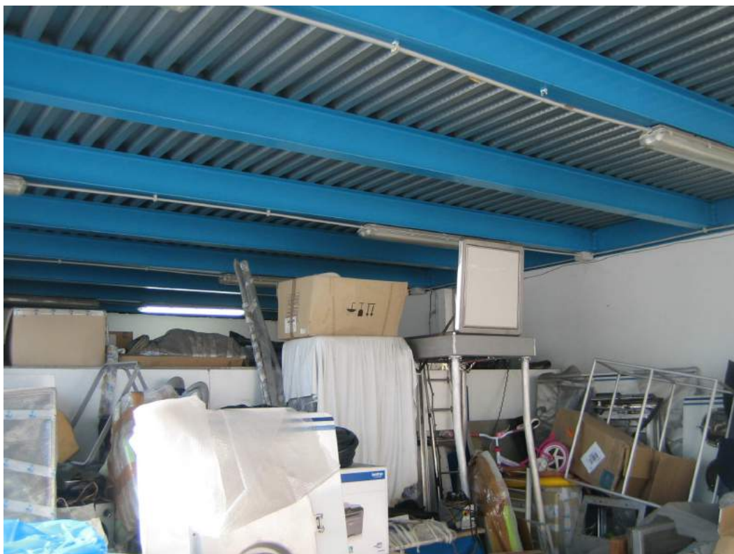
LOTTO 2 - foto n. 20 - Panoramica interna - Piano terra
