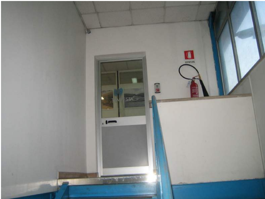
LOTTO 2 - foto n. 22 - Panoramica interna - Piano primo
