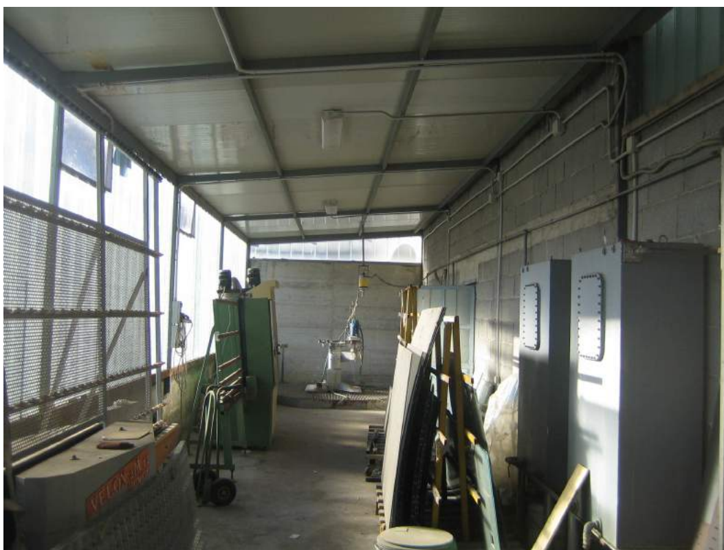
LOTTO 1 - foto n. 16 - Panoramica interna
