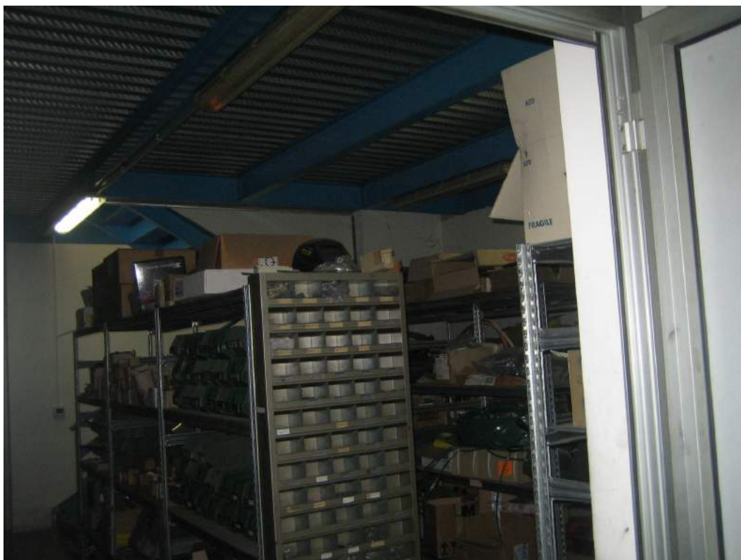
LOTTO 2 - foto n. 21 - Panoramica interna - Piano terra
