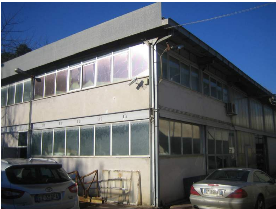
LOTTO 2 - foto n. 18 - Panoramica esterna
