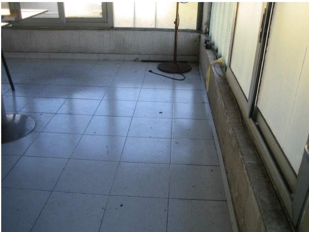
LOTTO 1 - foto n. 14 - Panoramica interna
