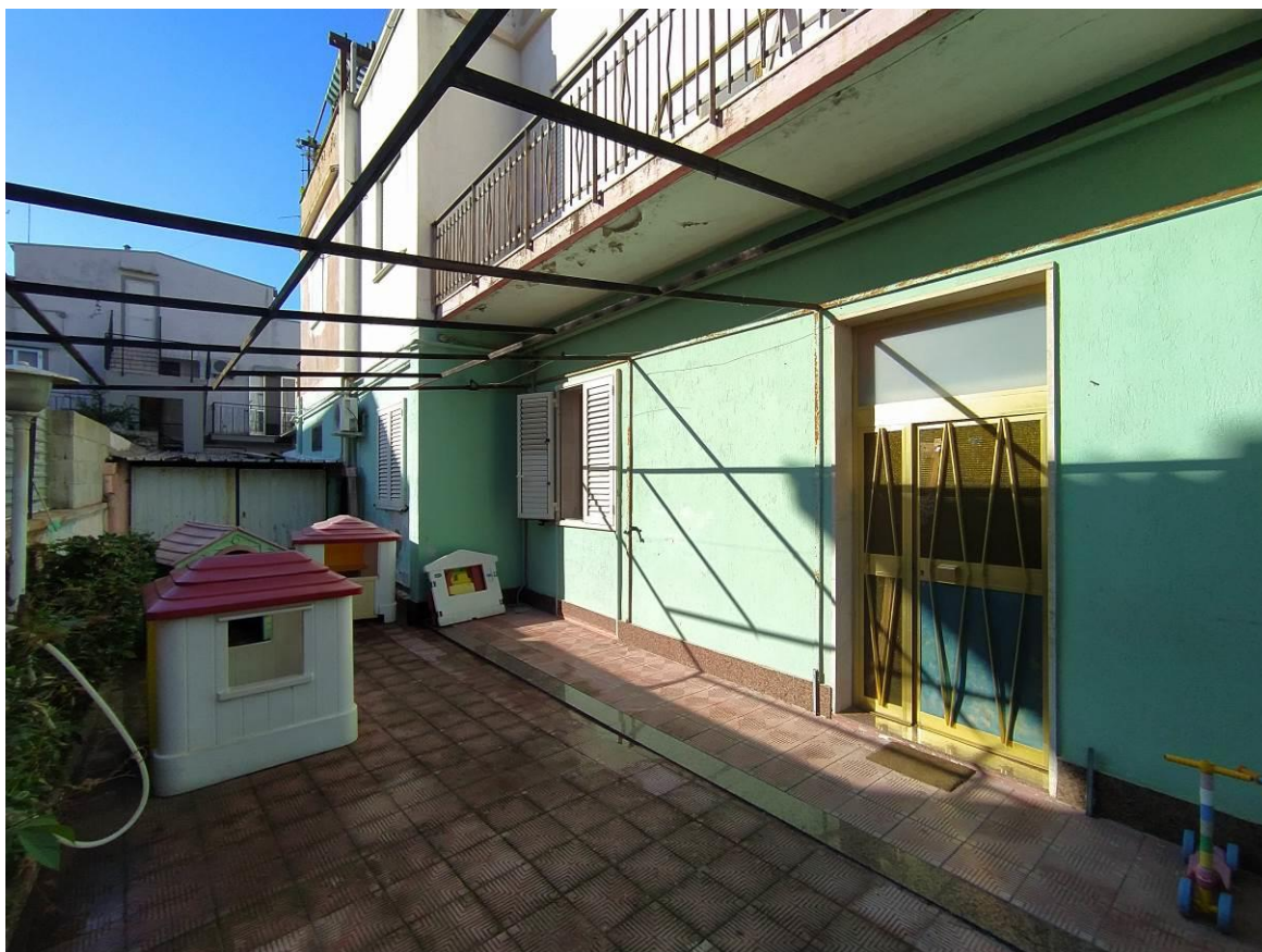
Foto 4 – A destra, portone d'ingresso al fabbricato; a sinistra, accesso all'autorimessa
