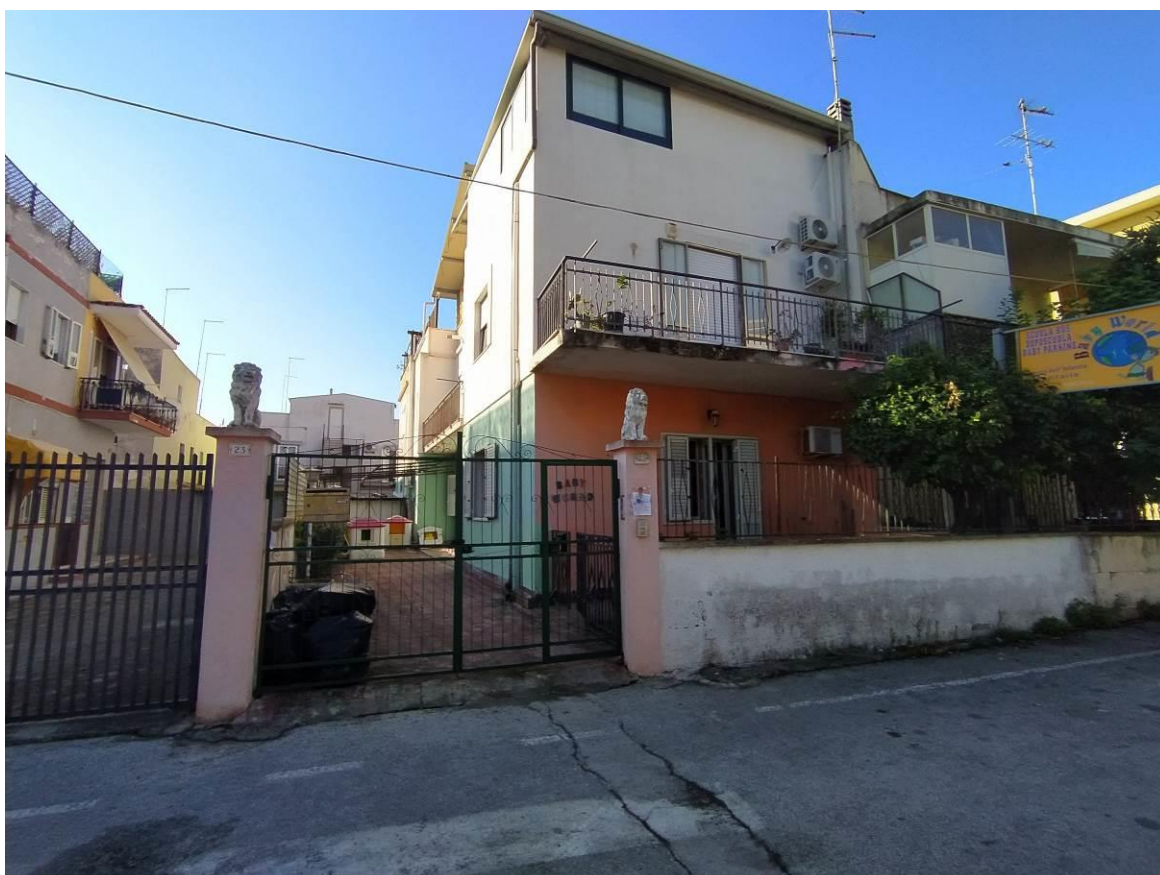
Foto 2 – Prospetto nord su Via Ungheria
