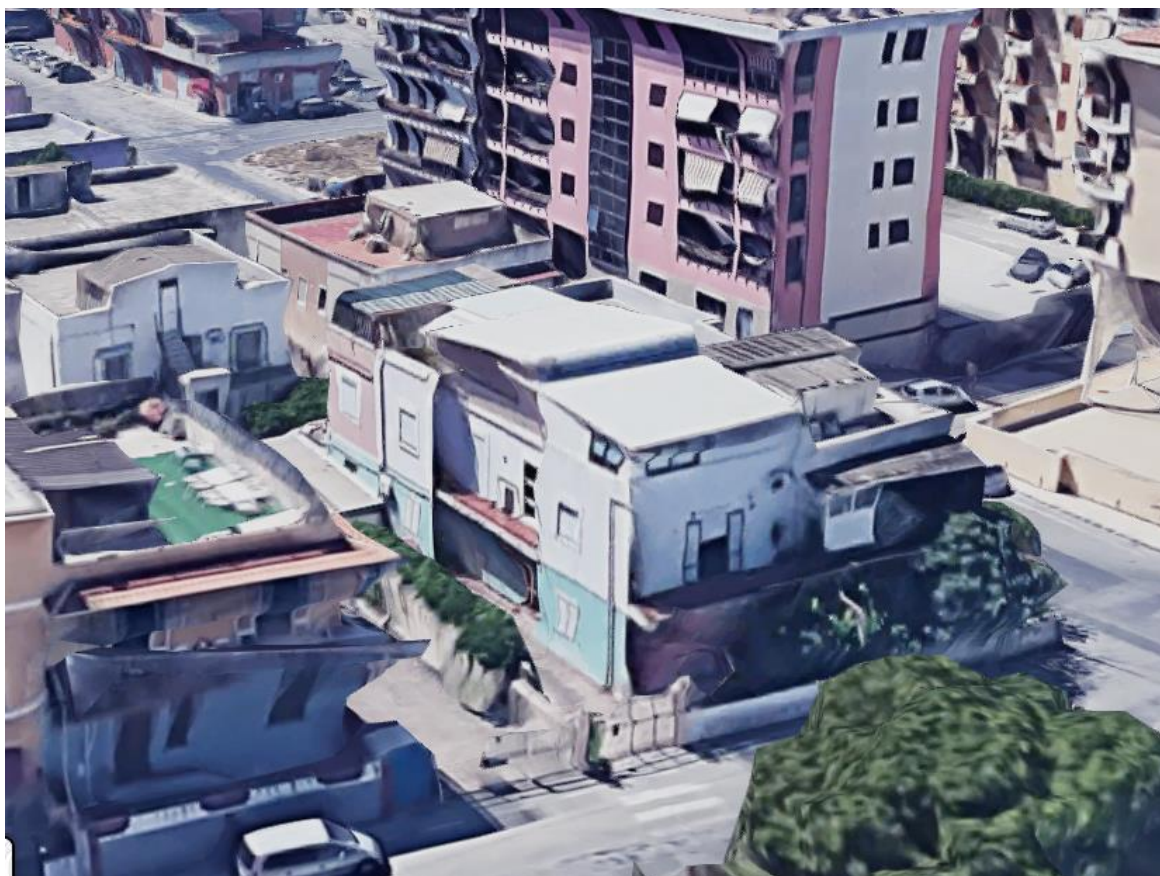
Foto 1 – Immagine aerea del fabbricato (fonte Google)
