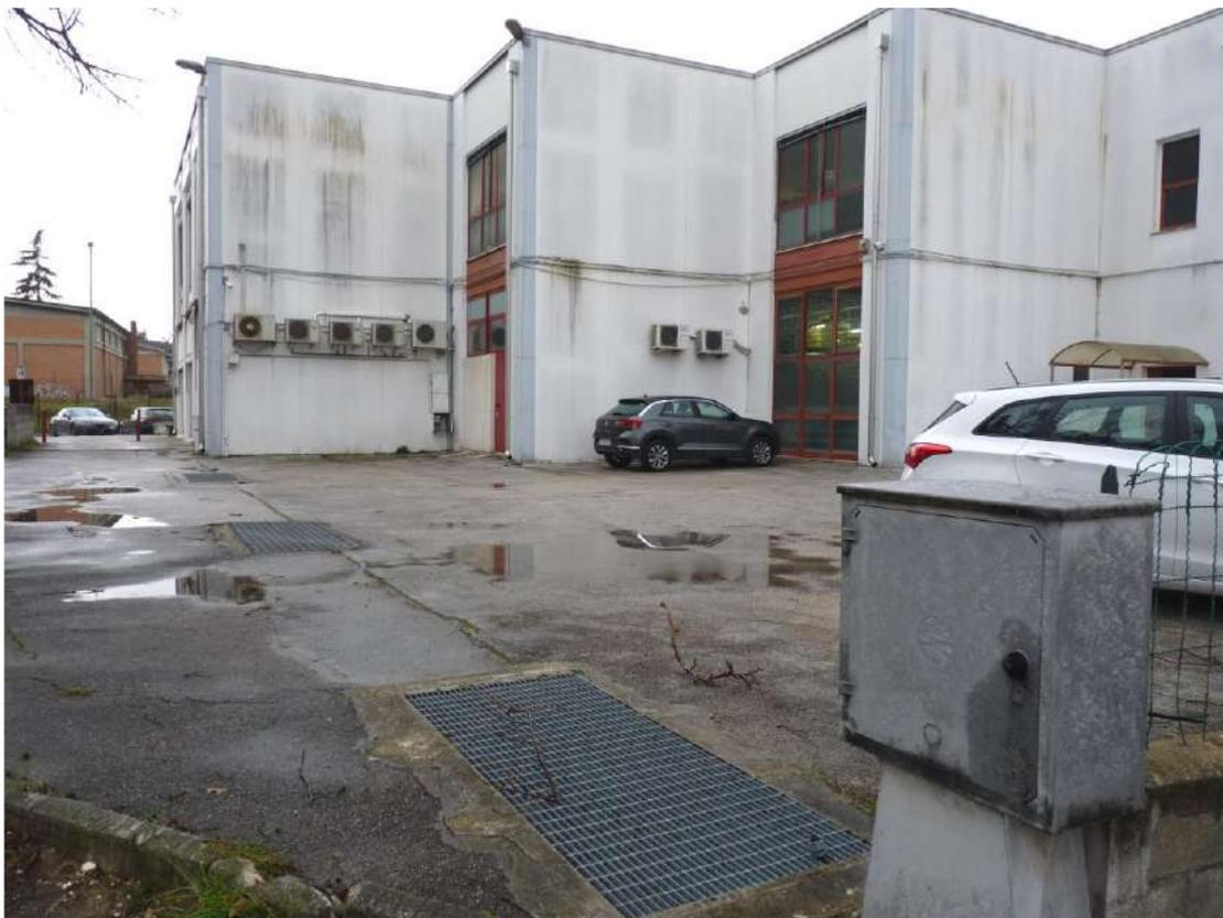
**Foto alleg. n°17** – Vista delle griglie metalliche corrispondenti alle bocche di lupo presenti lungo la parete controterra lato sud-ovest del locale magazzino (sub.25).
