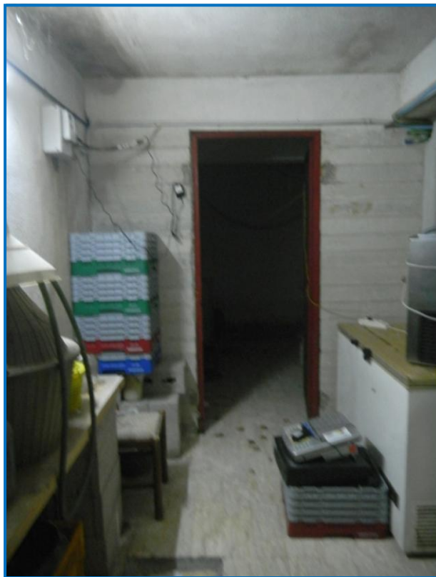
Foto n° 17 – magazzino piano terra con ingresso dal 1° piano
