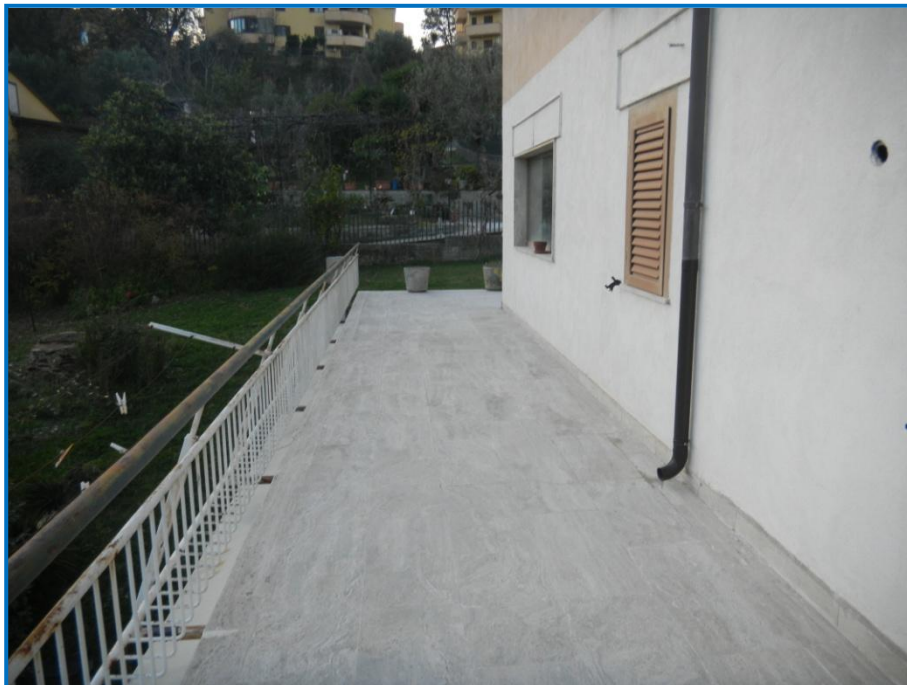
Foto n° 6 - Balcone prospetto anteriore
