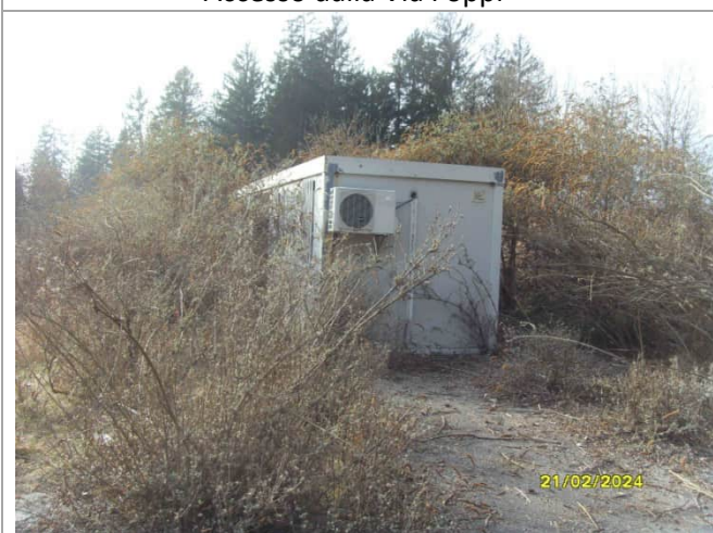
Container di cantiere – zona nord
