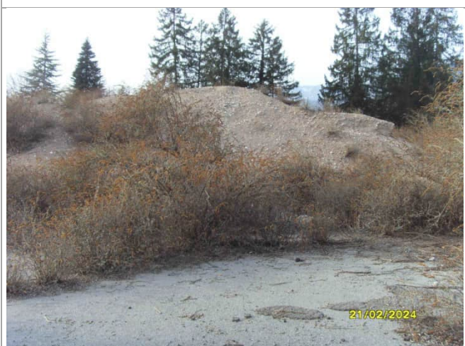
Detriti di cantiere presenti – zona nord ovest
