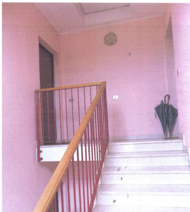
Vista del vano scala comune
