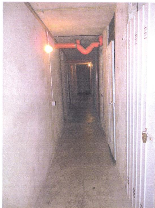
Vista del corridoio comune delle cantine
