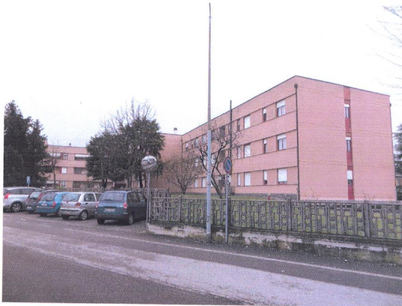
Vista dell'edificio da via Santa Elisabetta
