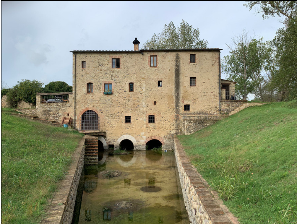
Veduta del prospetto orientale del fabbricato
