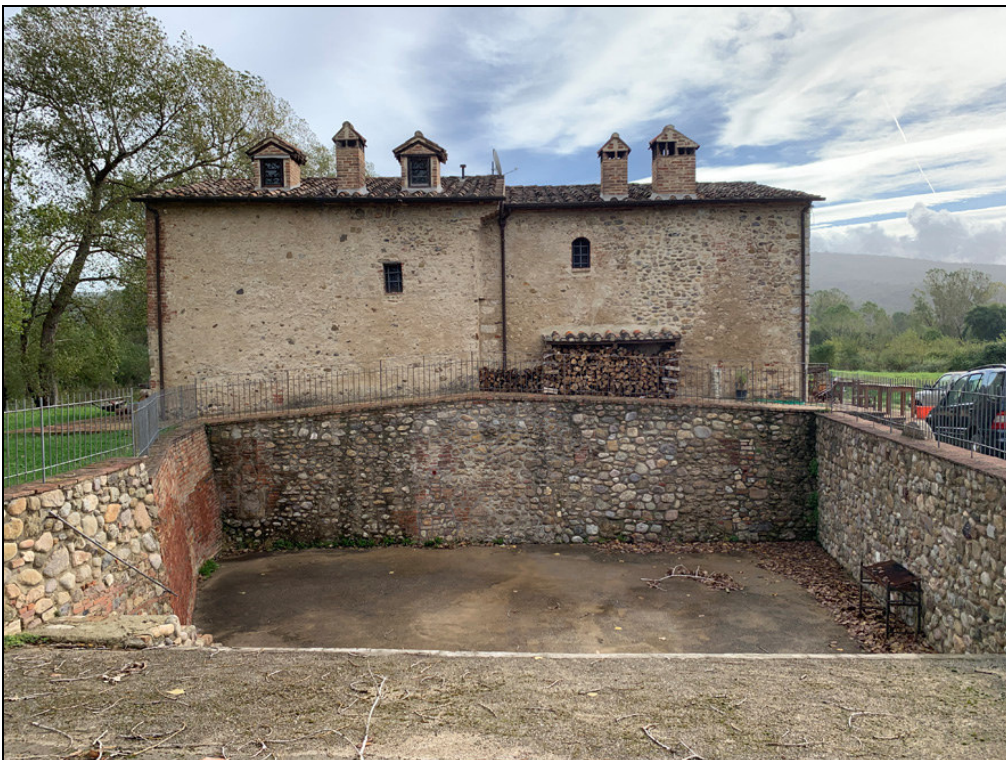
Veduta del camminamento laterale di attraversamento
