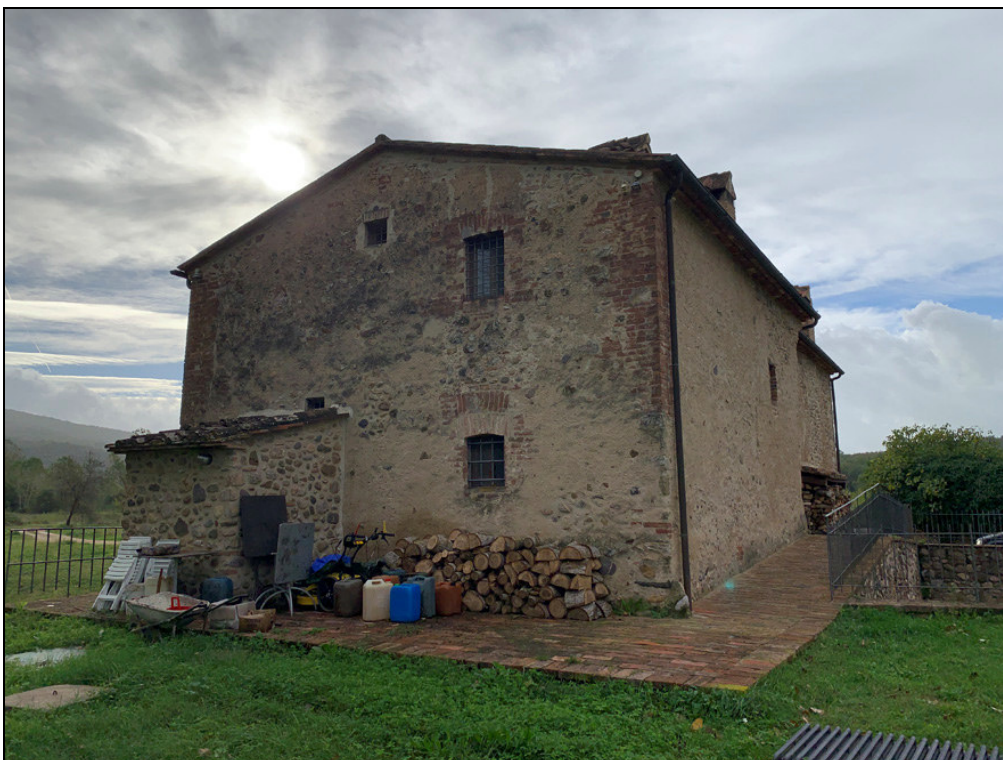
Immagine del retro del fabbricato e del locale tecnico/ripostiglio
