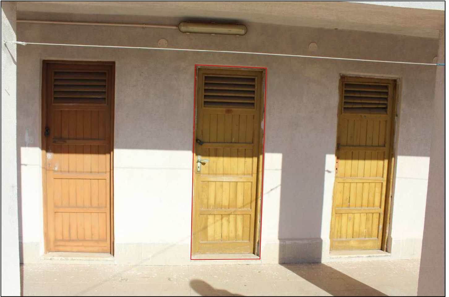
F.6 –Ripostiglio a piano terrazza
