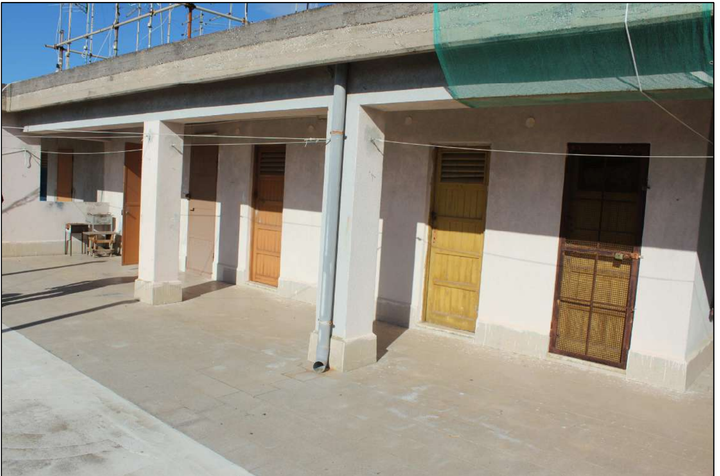
F.7 –Ripostiglio a piano terrazza
