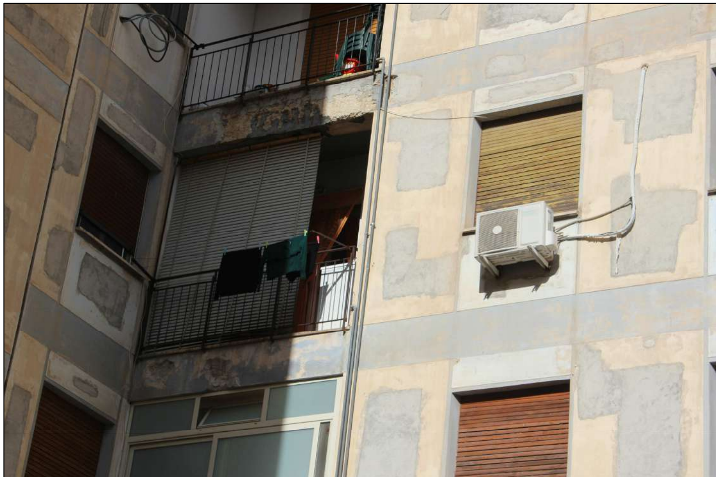
F.4 – Vista loggia (Sud) confinante con Cucina
