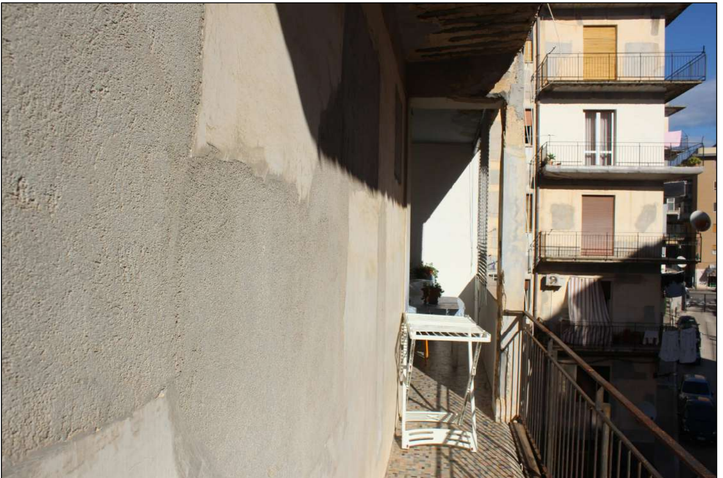
N.16 Balcone lato Est
