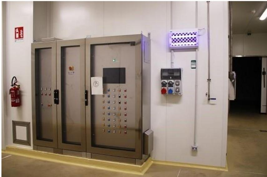
Quadro elettrico di controllo degli impianti di trattamento aria
