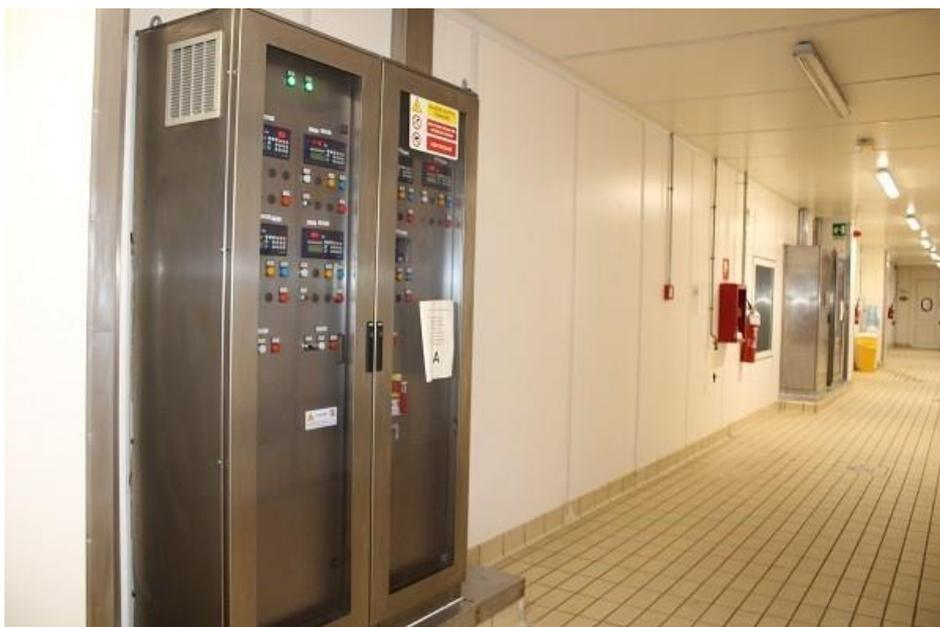
Quadro elettrico nel reparto produzione per il controllo delle celle
