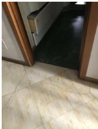
Lesioni a pavimento a ridosso della forometria scala interna
