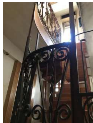
Patologie da umidità nel centrale
