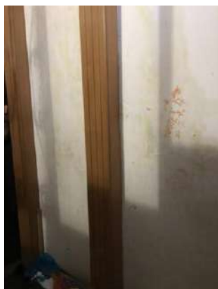
Patologie da umidità nel vano a nord e nel disimpegno
