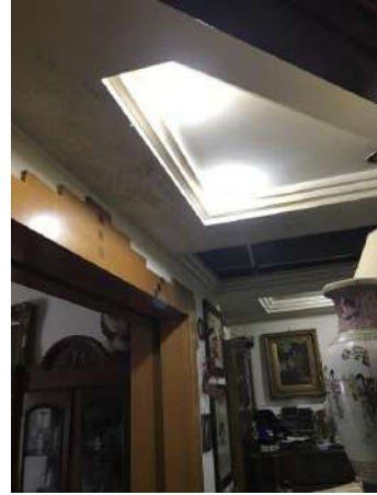
Vista di riparazioni e patologie da infiltrazione per malfunzionamento dell'impianto di climatizzazione
