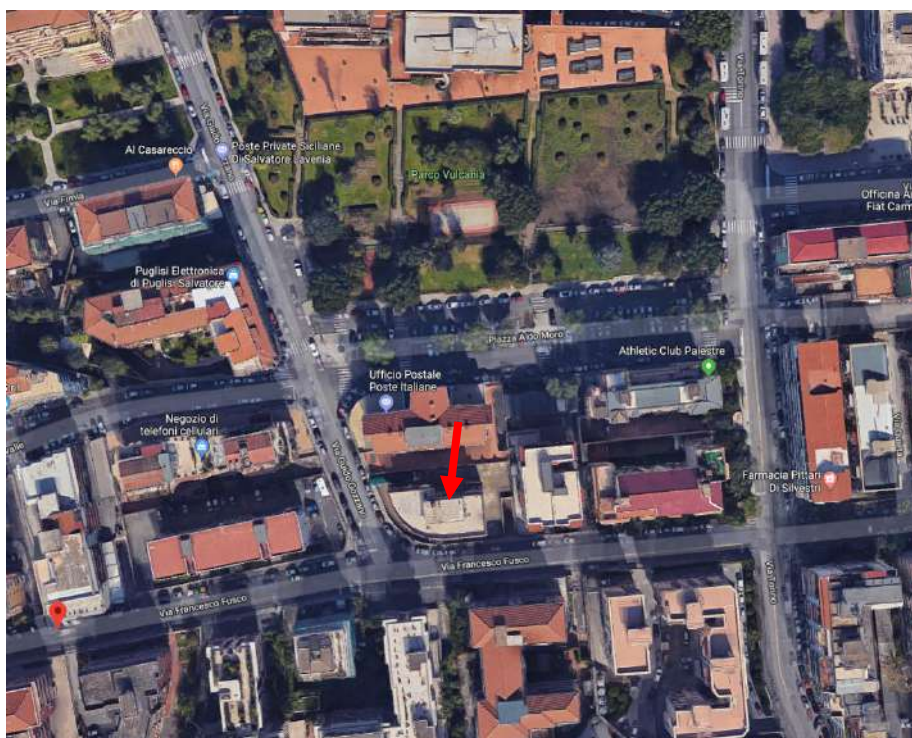
Vista satellitare con localizzazione del fabbricato condominiale con accesso dal civ.37 della via F. Fusco
