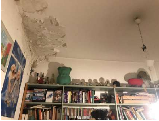
Patologie da umidità nel vano a nord
