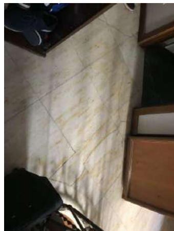
Lesioni a pavimento a ridosso della forometria scala interna
