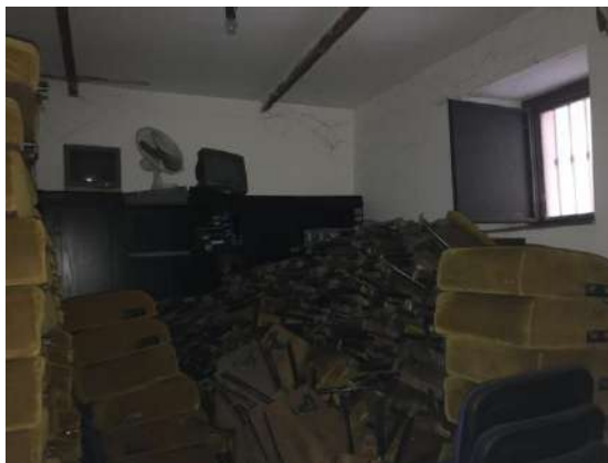
Vista del wc e del vano laterale
