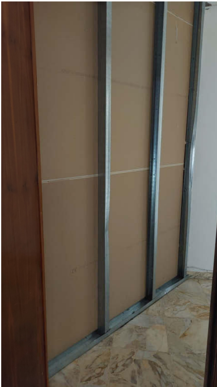
Foto n.12: Divisione in cartongesso provvisoria (retro)
