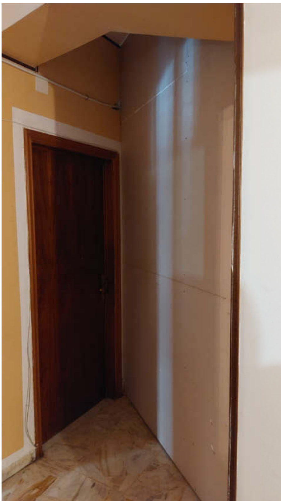
Foto n.8: Divisione in cartongesso provvisoria
