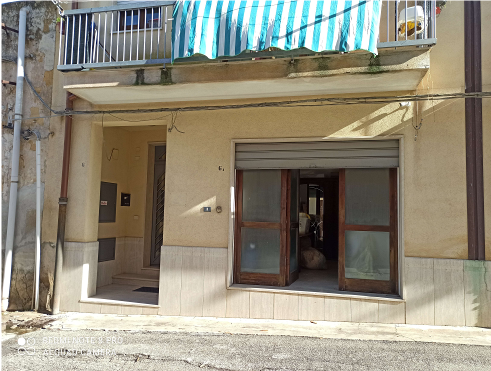
Facciata si via Enea – autorimessa e androne
