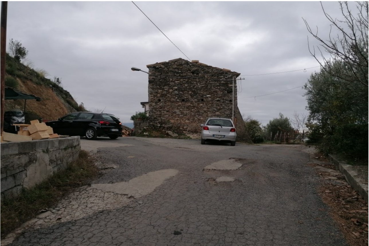
Foto n° 4 – Fine tratto strada privata di accesso da Strada Provinciale n. 257 (immobili interessati NON visibili sul retro del rudere) –
