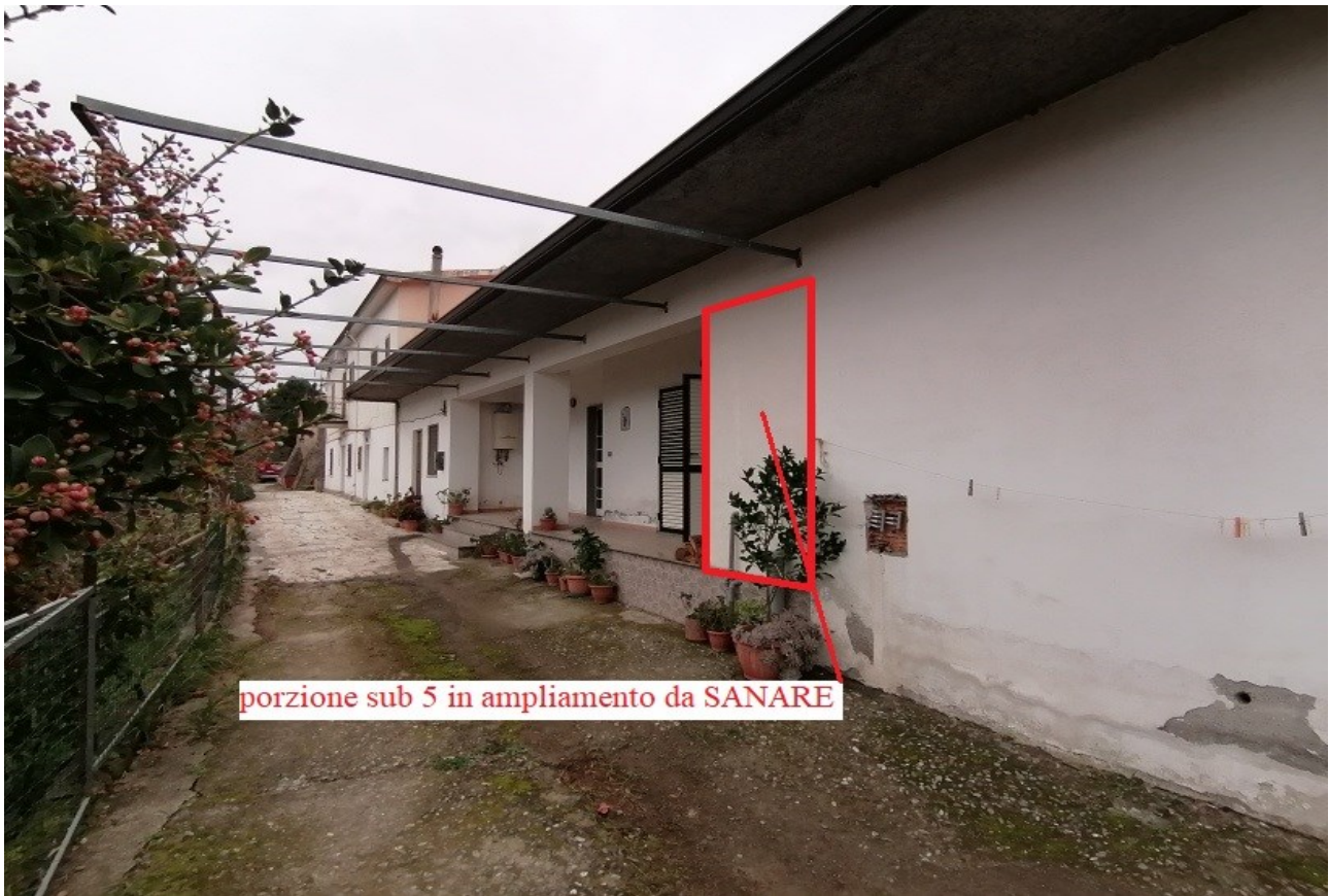
Foto n° 9 – Vista esterna con prospetto ovest degli immobili direzione nord -
