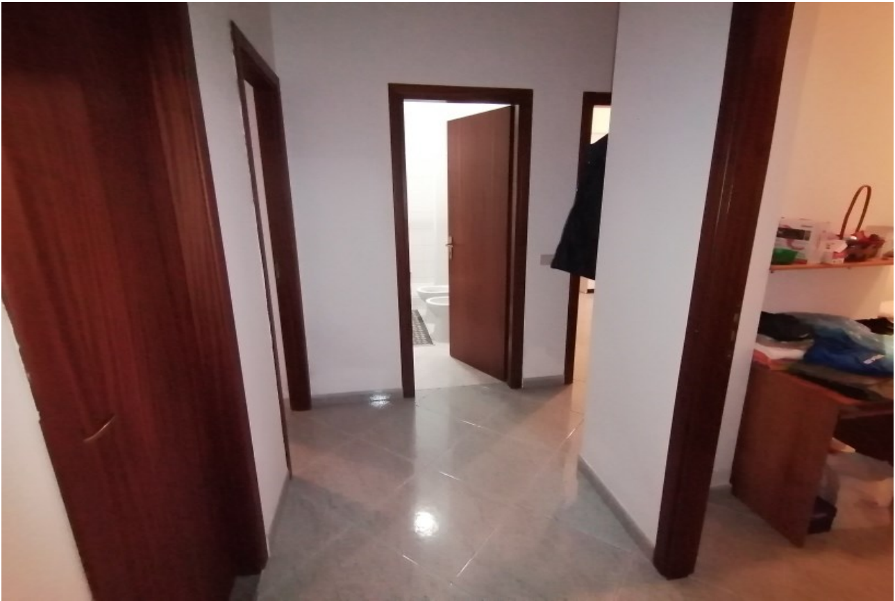
Foto n° 29 – Vista interna (disimpegno) –
