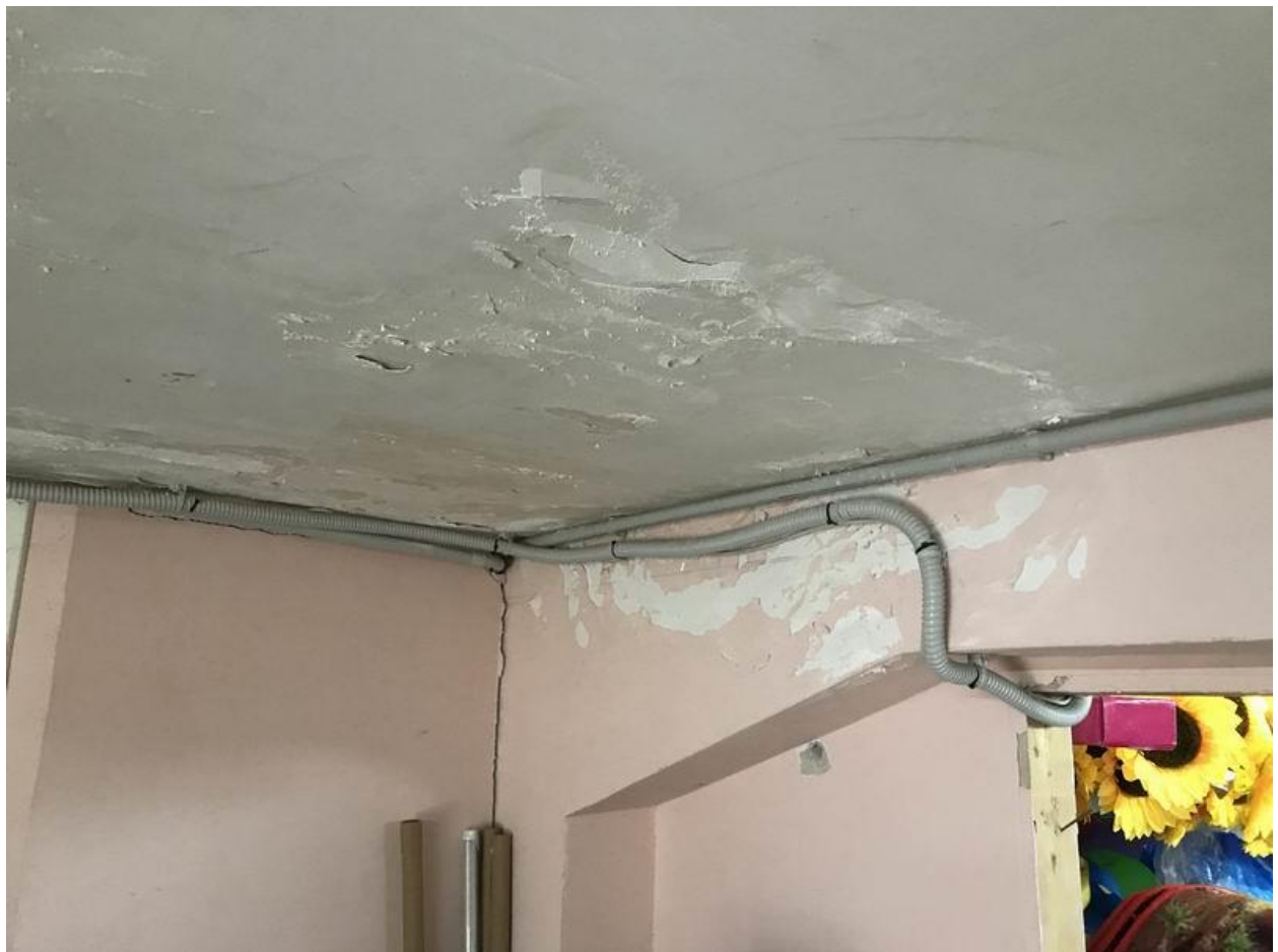
Particolari delle infiltrazioni provenienti dal sovrastante terrazzo (alieno)
