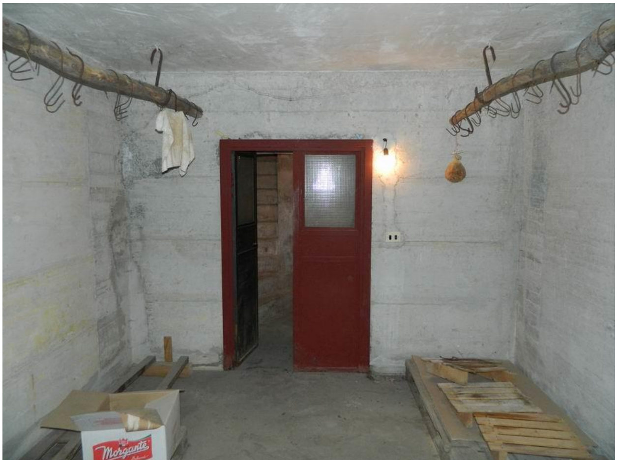
Vista degli interni del piano seminterrato
