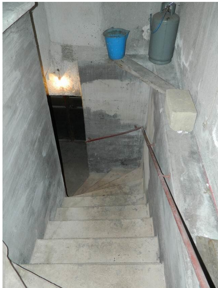
Scala di accesso al piano seminterrato
