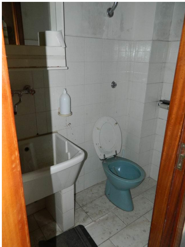
Vista degli interni del piano terra
