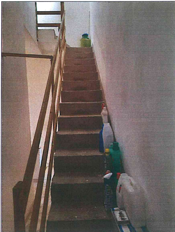
Foto 15-16 - Foto della scala (da demolire ai fini della sanatoria) che conduce al secondo piano, non rivestita e con ringhiera in legno. Foto del ripostiglio del secondo piano, volume abusivo rispetto al progetto del 1978.
