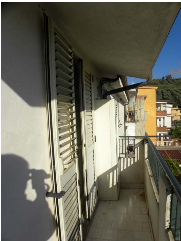
Foto 13 – Balcone del bene oggetto di pignoramento
