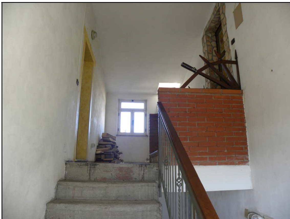
Foto 04 – Scala di accesso al bene oggetto di pignoramento
