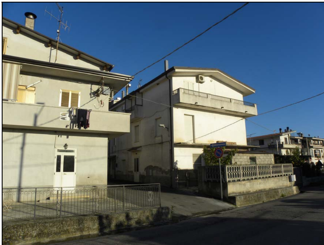
Foto 02 – Fabbricato dove è posto il bene oggetto di pignoramento
