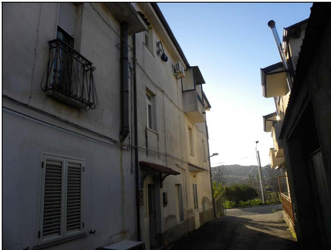
Foto 03 – Ingresso Fabbricato dove è posto il bene oggetto di pignoramento da Via Locri
