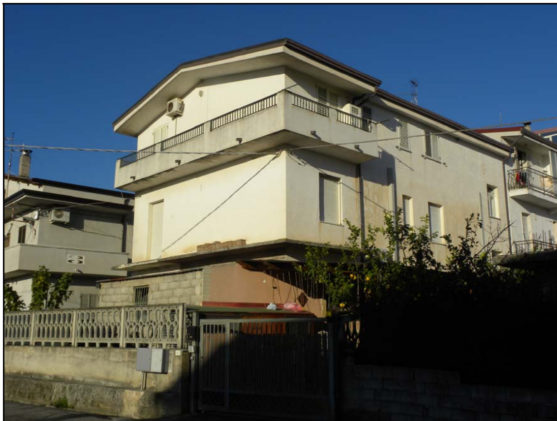
Foto 01 – Fabbricato dove è posto il bene oggetto di pignoramento
