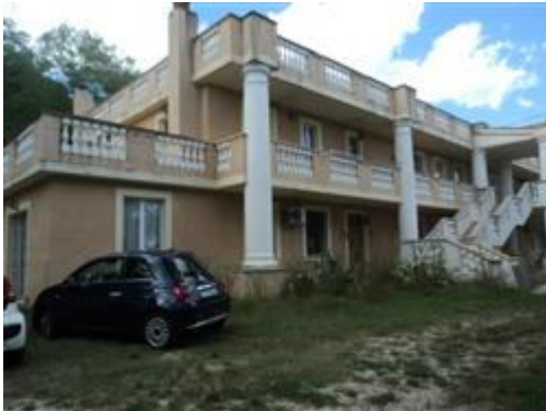
Edificio Principale con scala esterna e ballatoio
