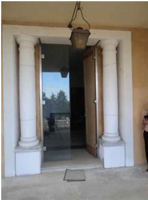
Ingresso Ristorante con portone in vetro
