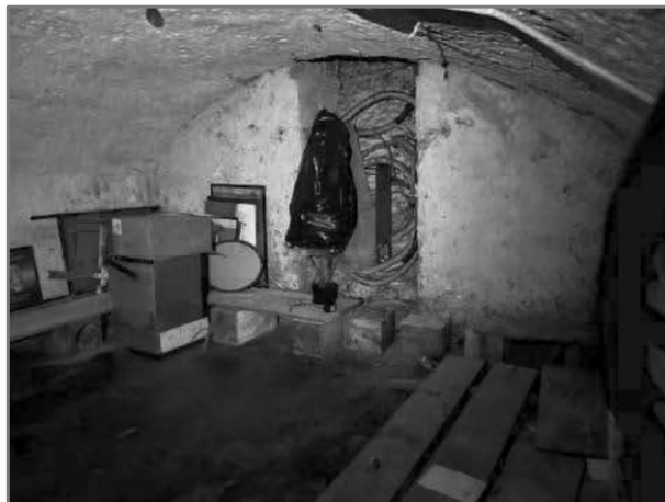
14. Cantina piano interrato
