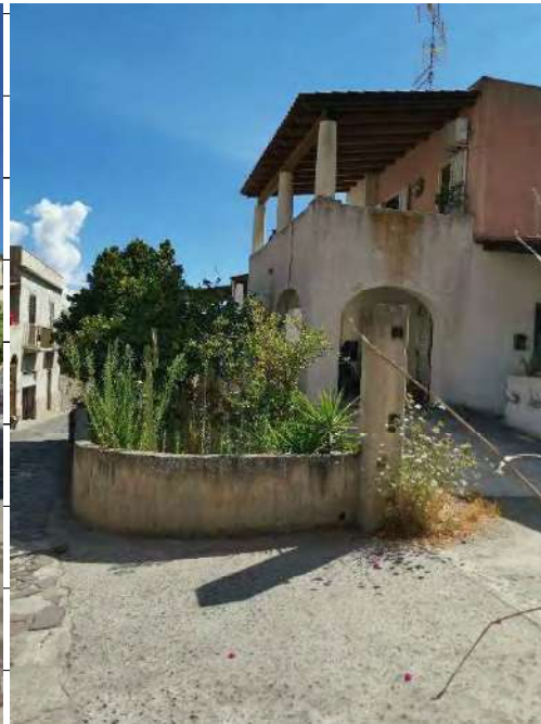
2-Vista Sud-Ovest dell'Immobile dal Torrente Aurora
