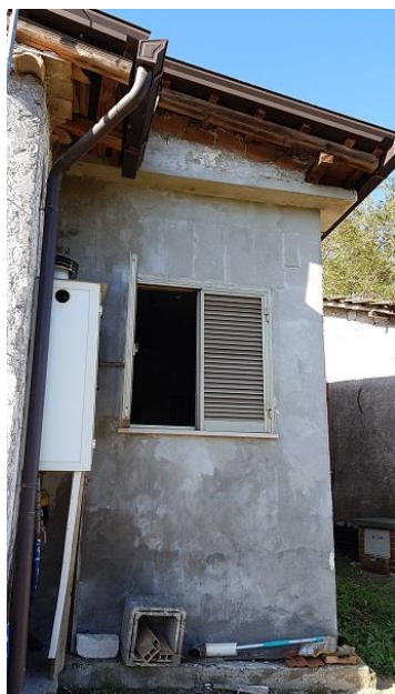
VISTA DEL LOCALE BAGNO
