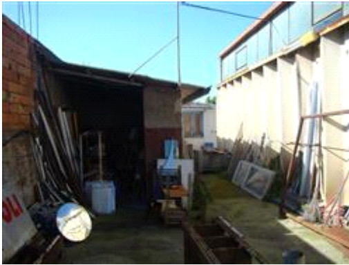
Difformità edificio secondario
