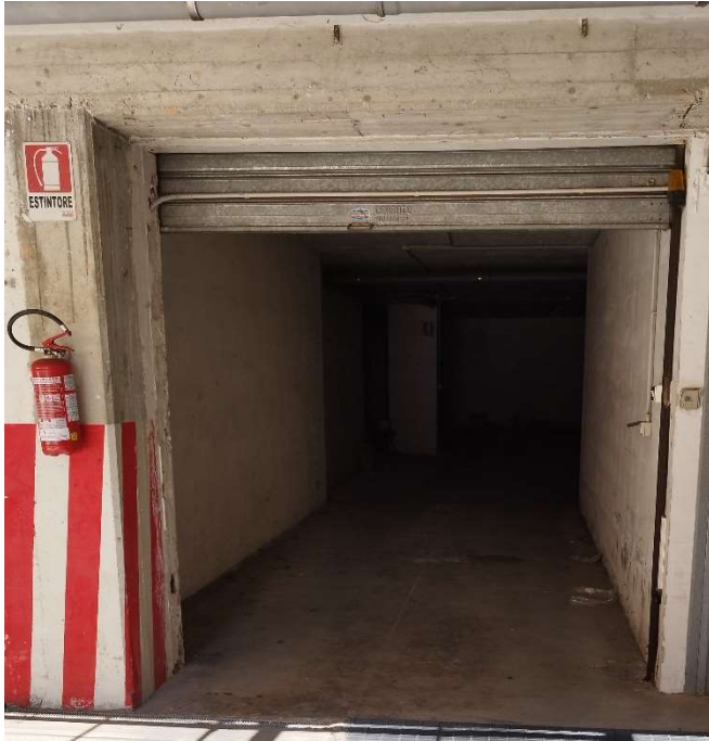
Foto 16 –Ingresso deposito sub 217
