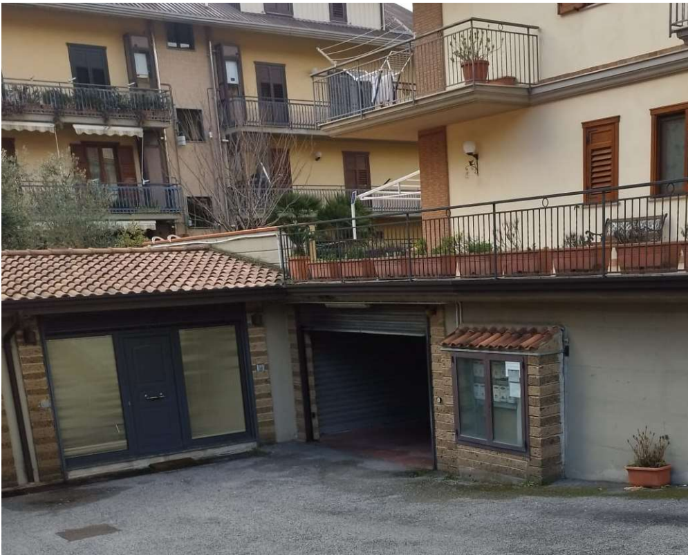
Foto 19 – Rampa di ingresso Deposito piano S1 – loc. Alvanella Monteforte Irp.
