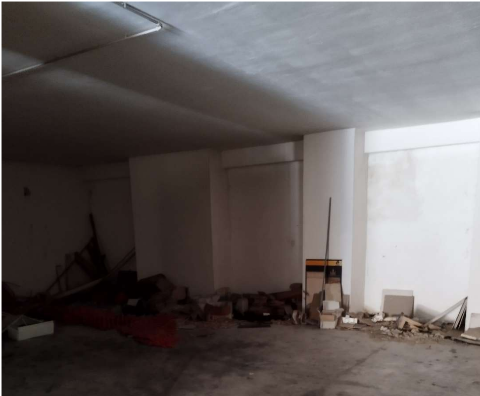
Foto 18 –Interno deposito sub 217
