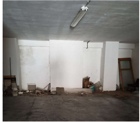
Foto 17 –Interno deposito sub 217
