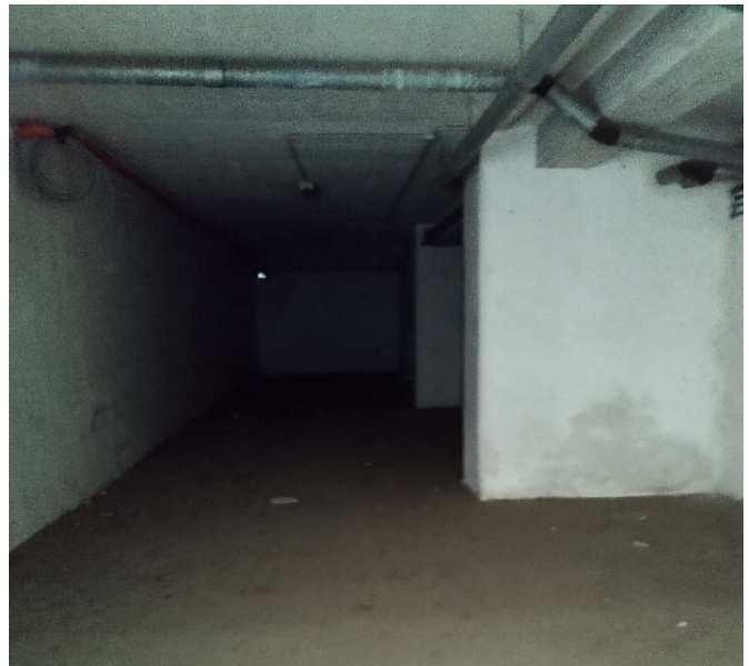
Foto 14 –Interno zona ingresso autorimessa sub 198
