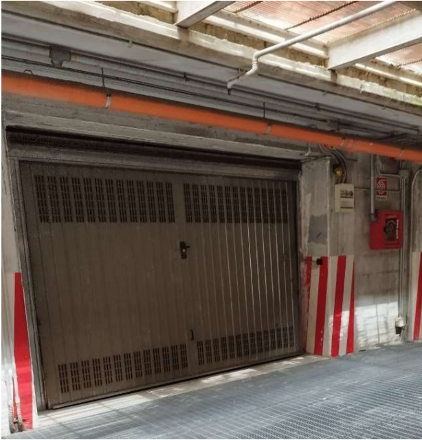
Foto 13 – Ingresso autorimessa sub 198
