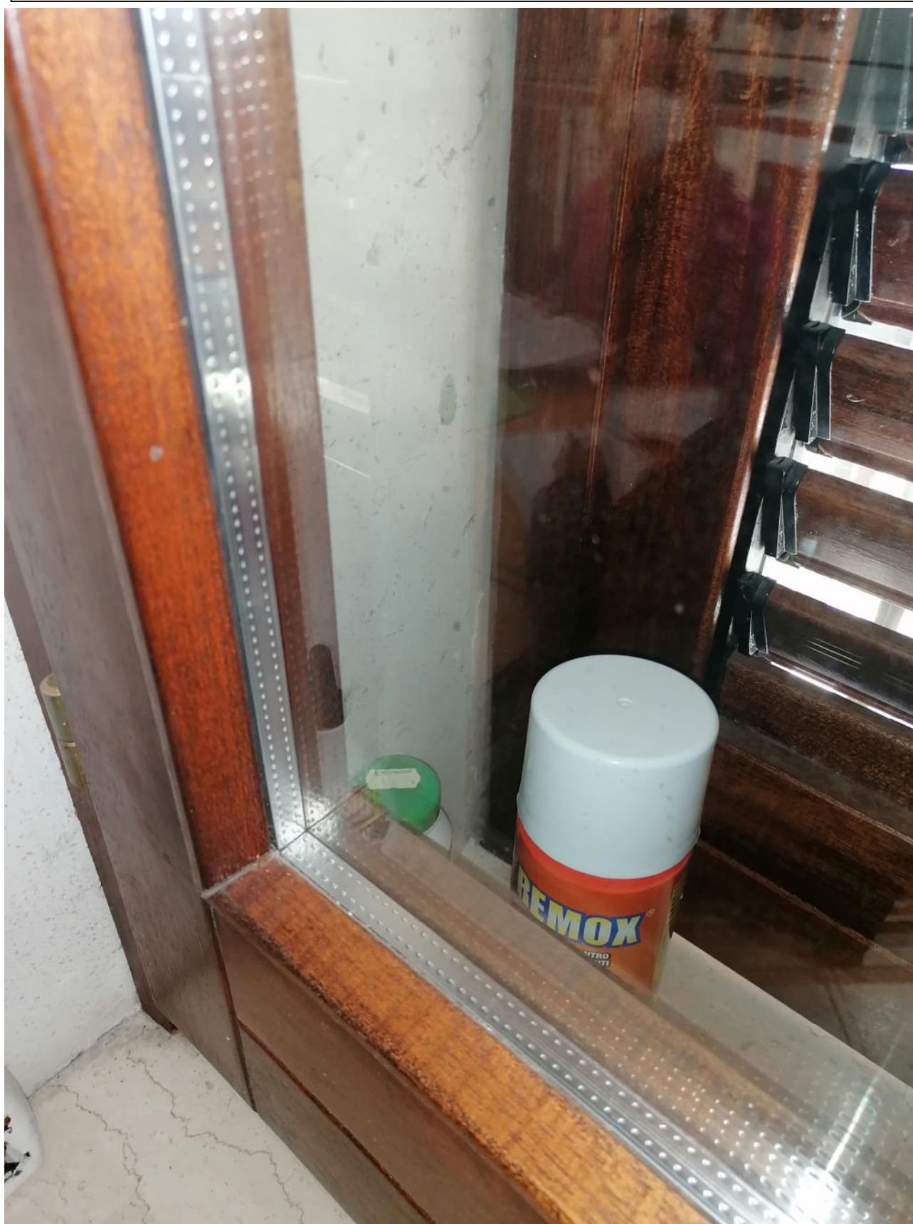
Foto 8 – Particolare dell'infisso e della persiana
