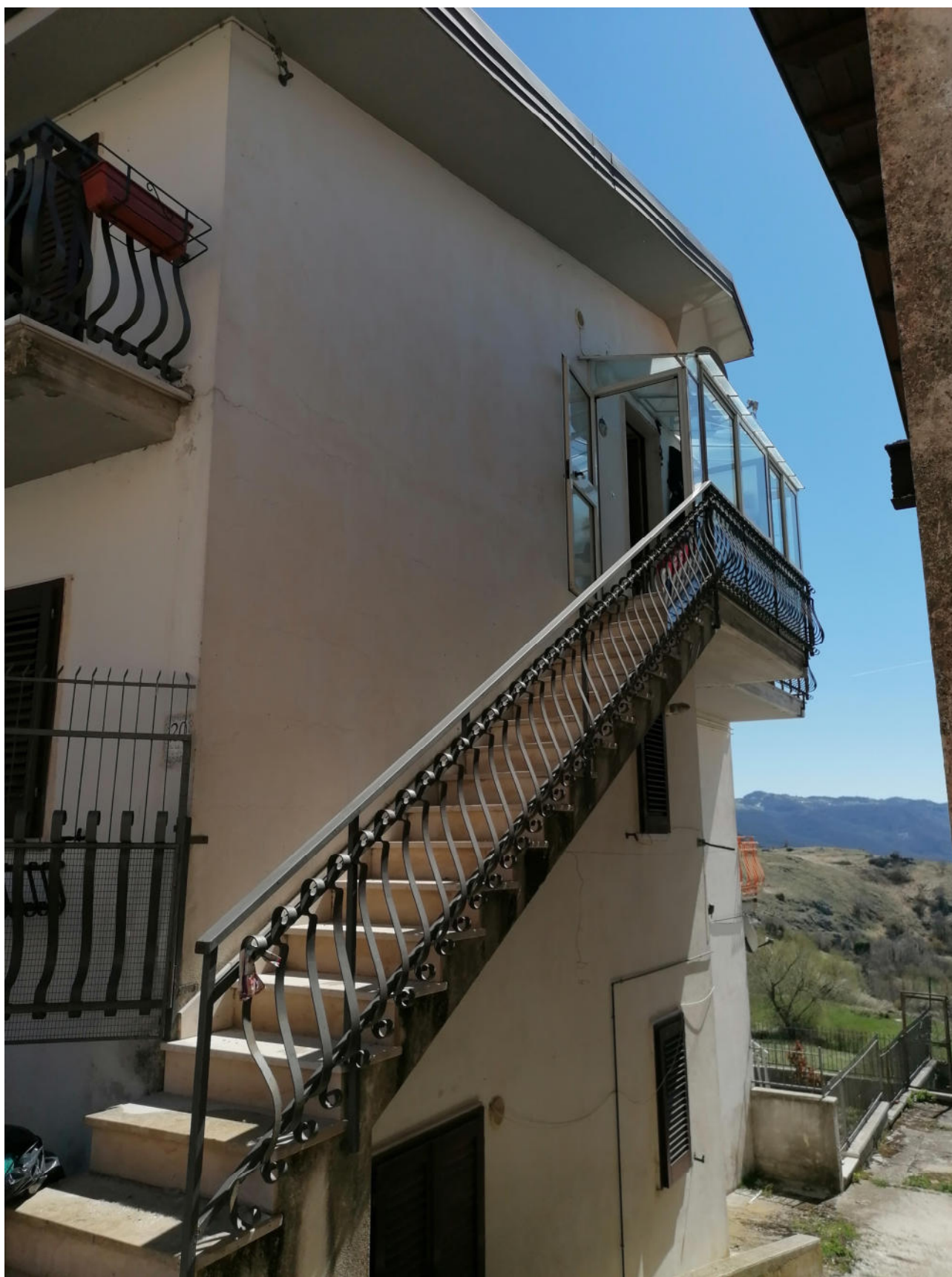
Foto 2 – Vista laterale della scala esterna di accesso al primo piano
