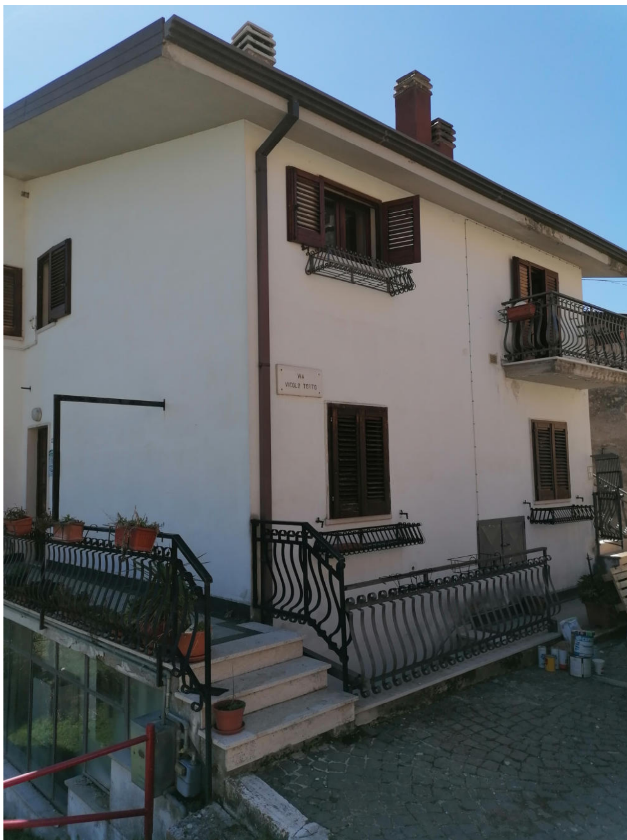
Foto 1 – Vista d'insieme su lato strada
