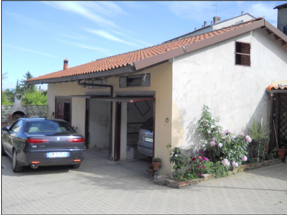
Immagine 4: Vista esterna del box auto
