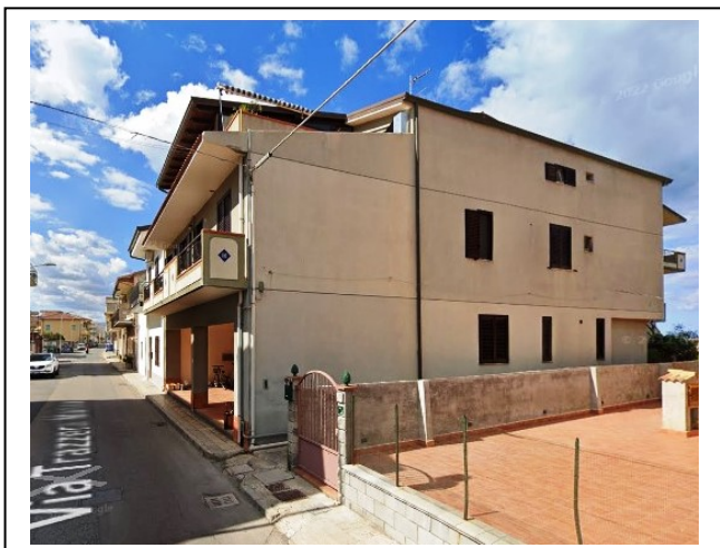
Foto 03. Fabbricato in cui ricade l'unità abitativa
