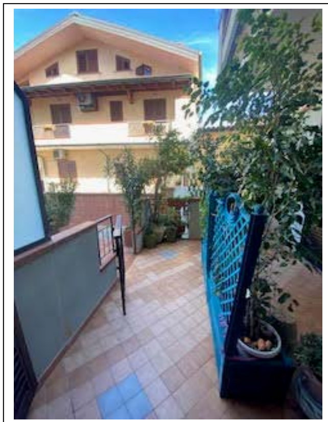
Foto 07./08. Facciata principale esposta a Nord-Est dell'unità abitativa N. 2. Spazio di entrata condiviso con l'appartamento n. 1
