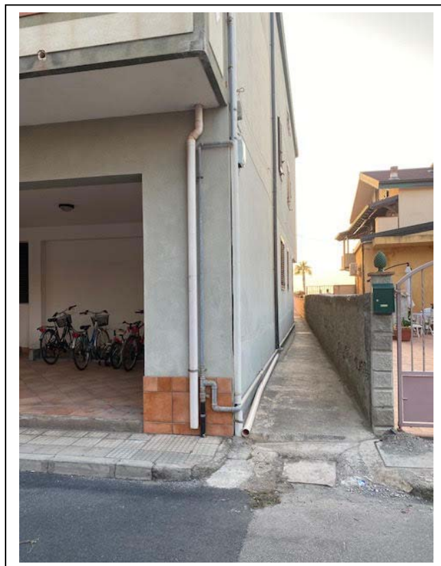
Foto 04. Ingresso pedonale con accesso da via Trazzera Marina.
