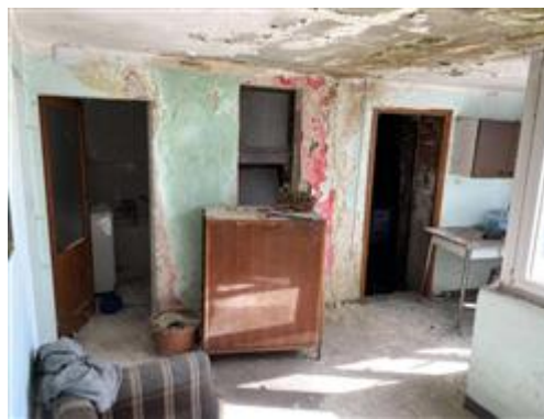
Disimpegno piano primo
