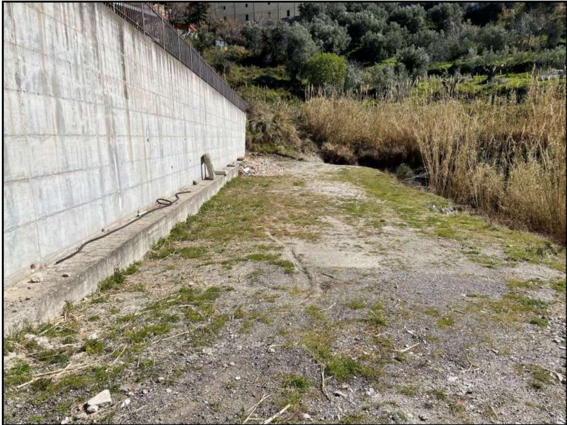
FOTO 9: Vista del muro di sostegno in c.a. realizzato all'interno del terreno
