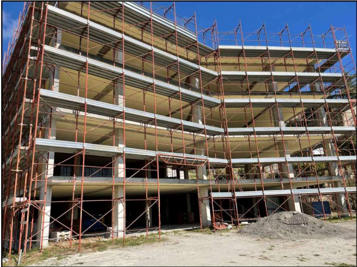
FOTO 5: Vista esterna del fabbricato non ultimato
