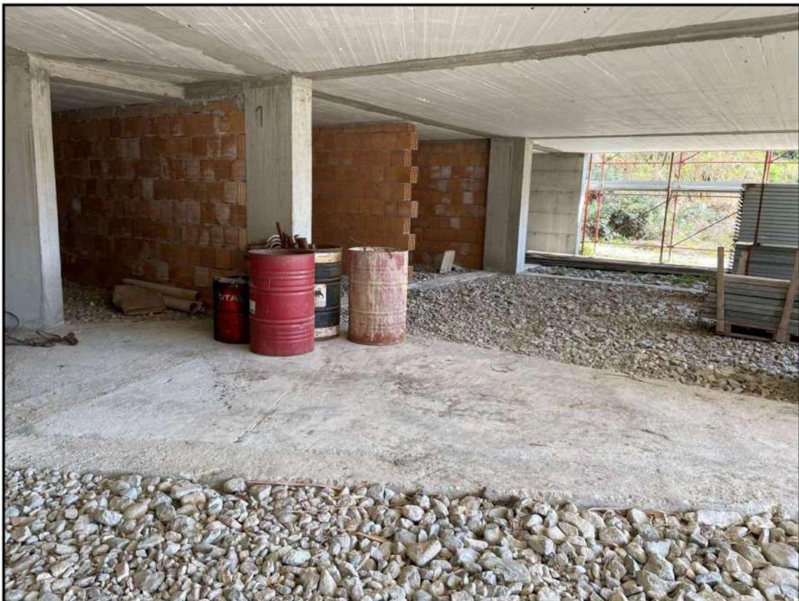
FOTO 6: Vista interna del fabbricato non ultimato
