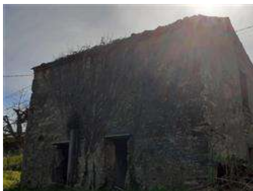
Prospetto a valle su strada vicinale (Nord/ovest)
