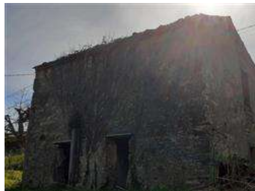
Prospetto a valle su strada vicinale (Nord/ovest)
