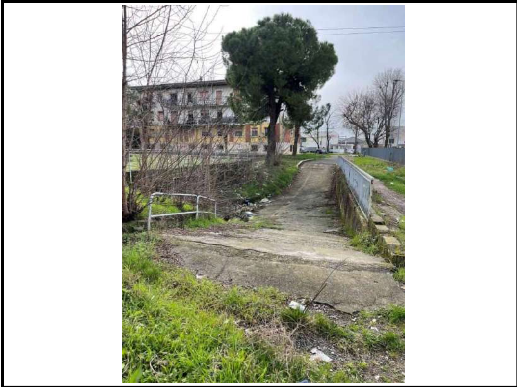
Foto 13 Rampa accesso autorimesse
