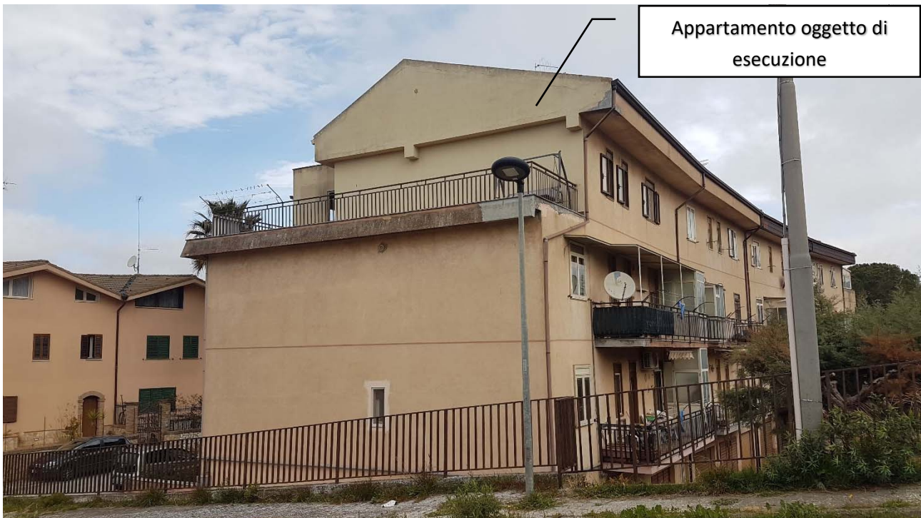
Foto n. 6 - 20220317_093926 – Prospetto laterale e secondario
