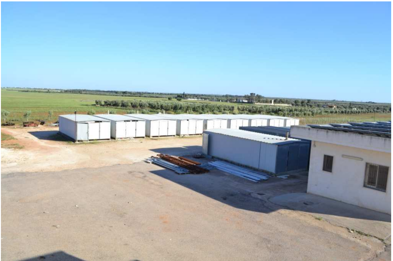
Vista dall'alto dei Forni per essiccamento tabacco
