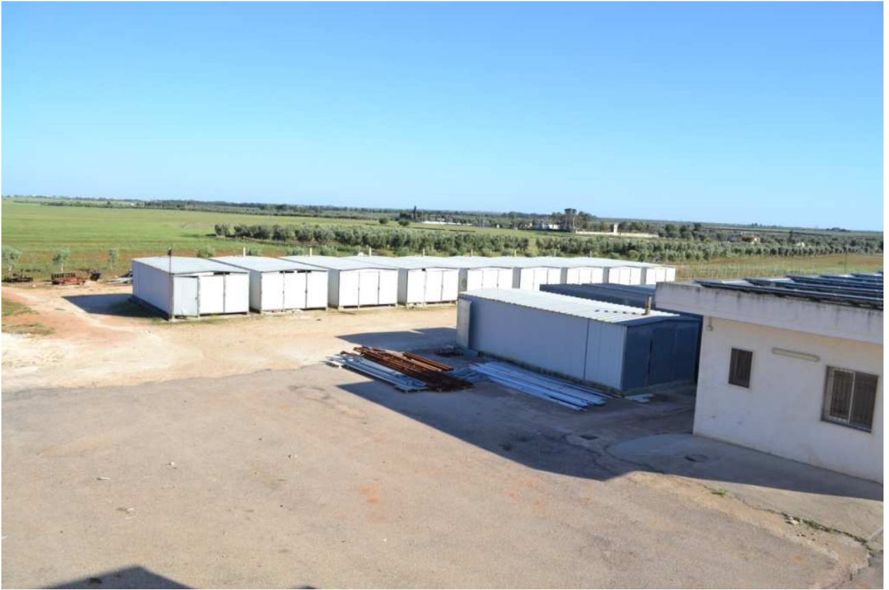
Vista dall'alto dei Forni per essiccamento tabacco
