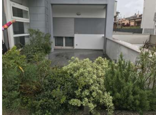
Prospetto su cortile di proprietà esclusiva
