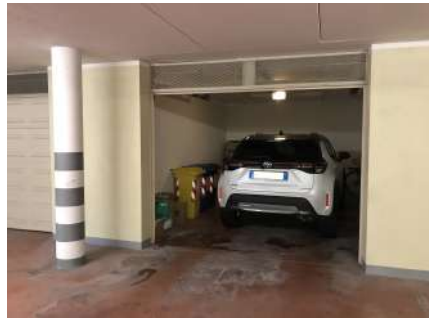
Foto 9-10 PS: garage diviso con muro in cartongesso
