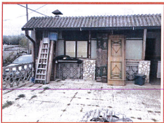
Foto 1 - Lato esterno fabbricato.
