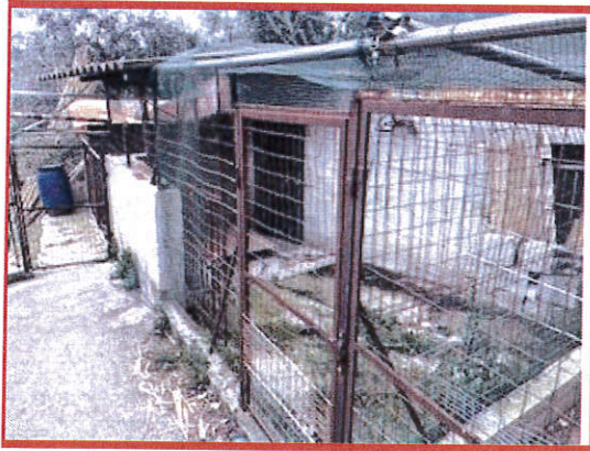
Foto 14 – Realizzazione di esigui manufatti in muratura per animali da cortile.
