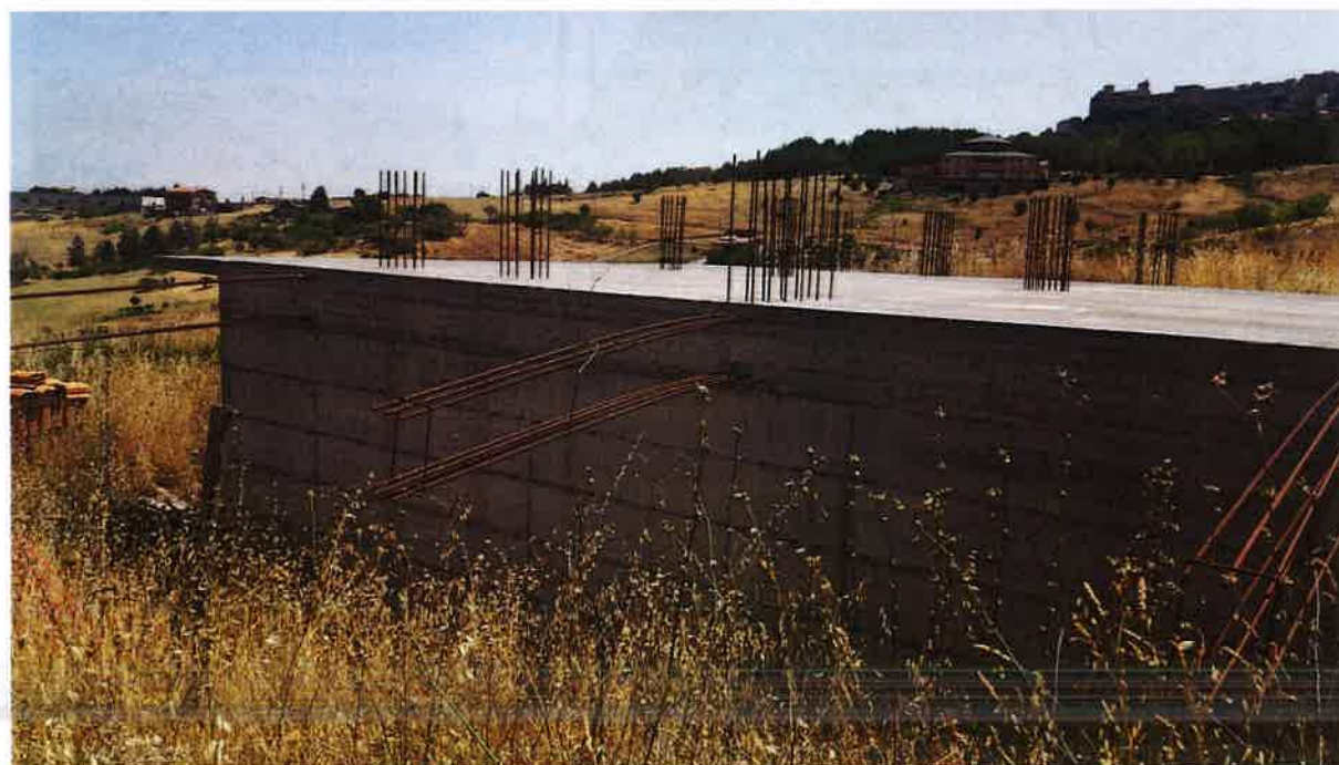
Foto 14 – Vista copertura fabbricato non censito terreno (D), fg. 26 part. 888, contrada Camatrona
