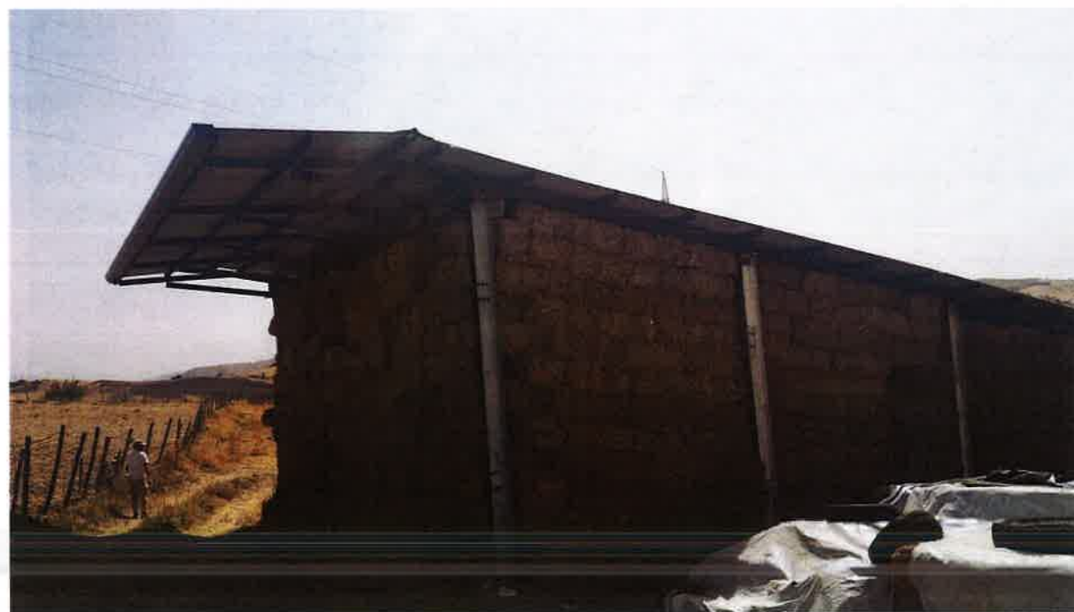
Foto 40 – Vista lato superiore fienile (A5) contrada Lavanche
