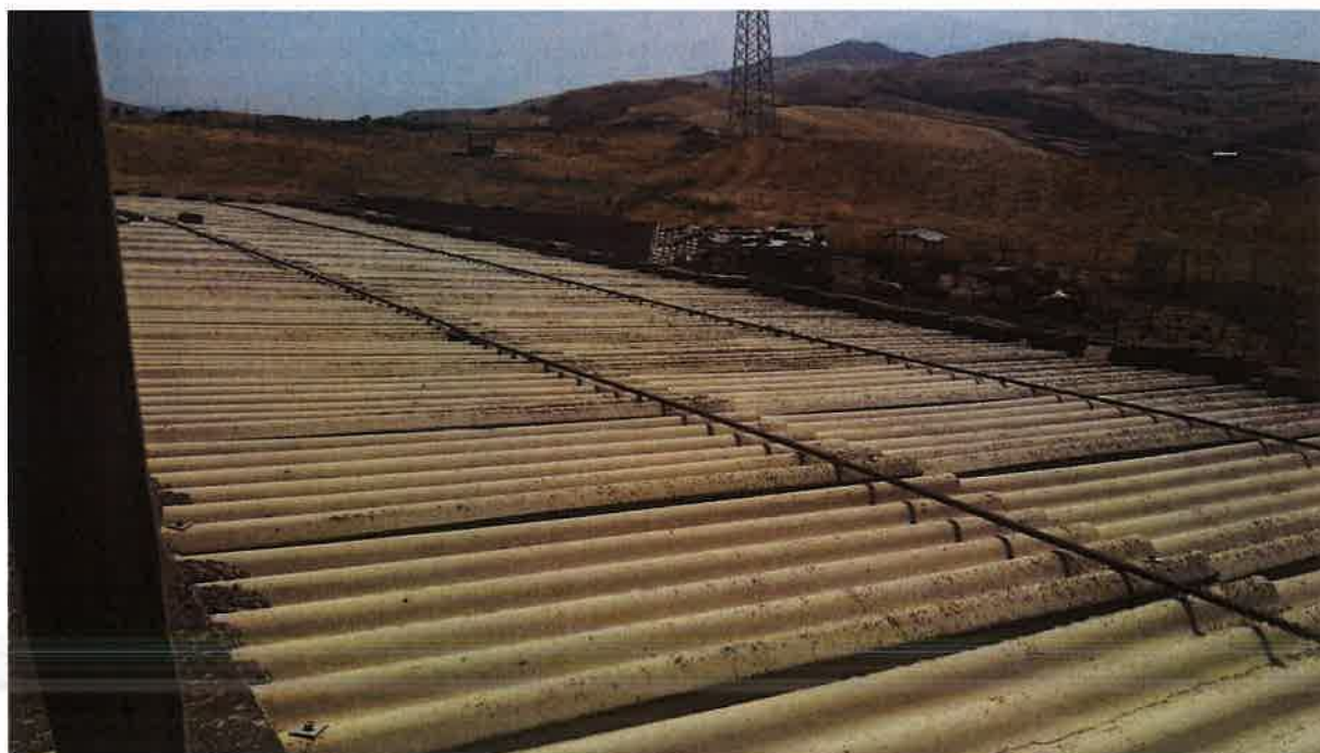
Foto 24 – Vista copertura stalla grande (A3), contrada Lavanche
