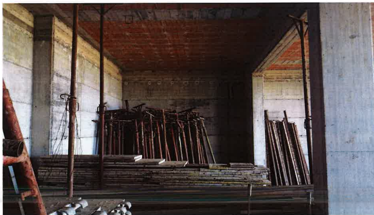
Foto 6 – Vista interna fabbricato non censito terreno (D), fg. 26 part. 888, contrada Camatrona
