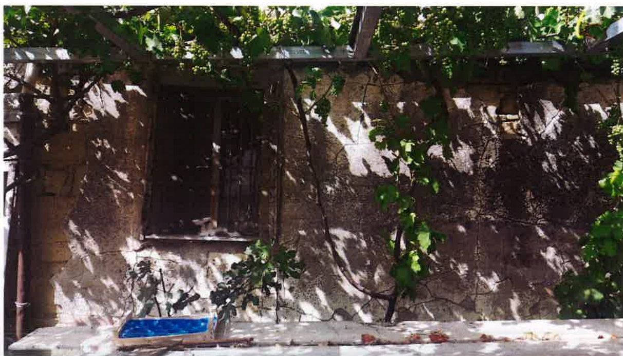
Foto 2 – Prospetto abitazione (A1) contrada Lavanche
