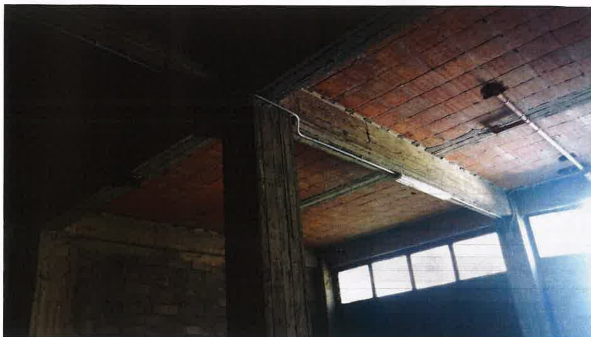
Foto 5 – Vista interna, particolare solaio autorimessa (E)
