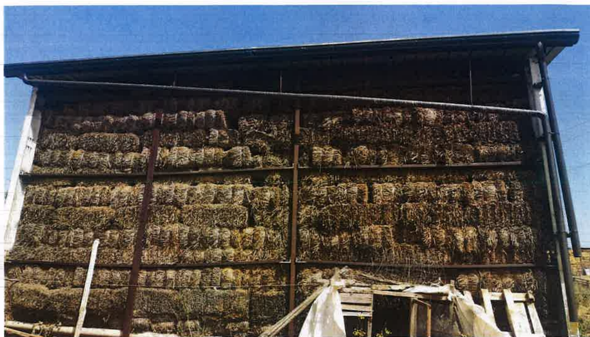
Foto 39 – Vista lato centrale fienile (A5) contrada Lavanche
