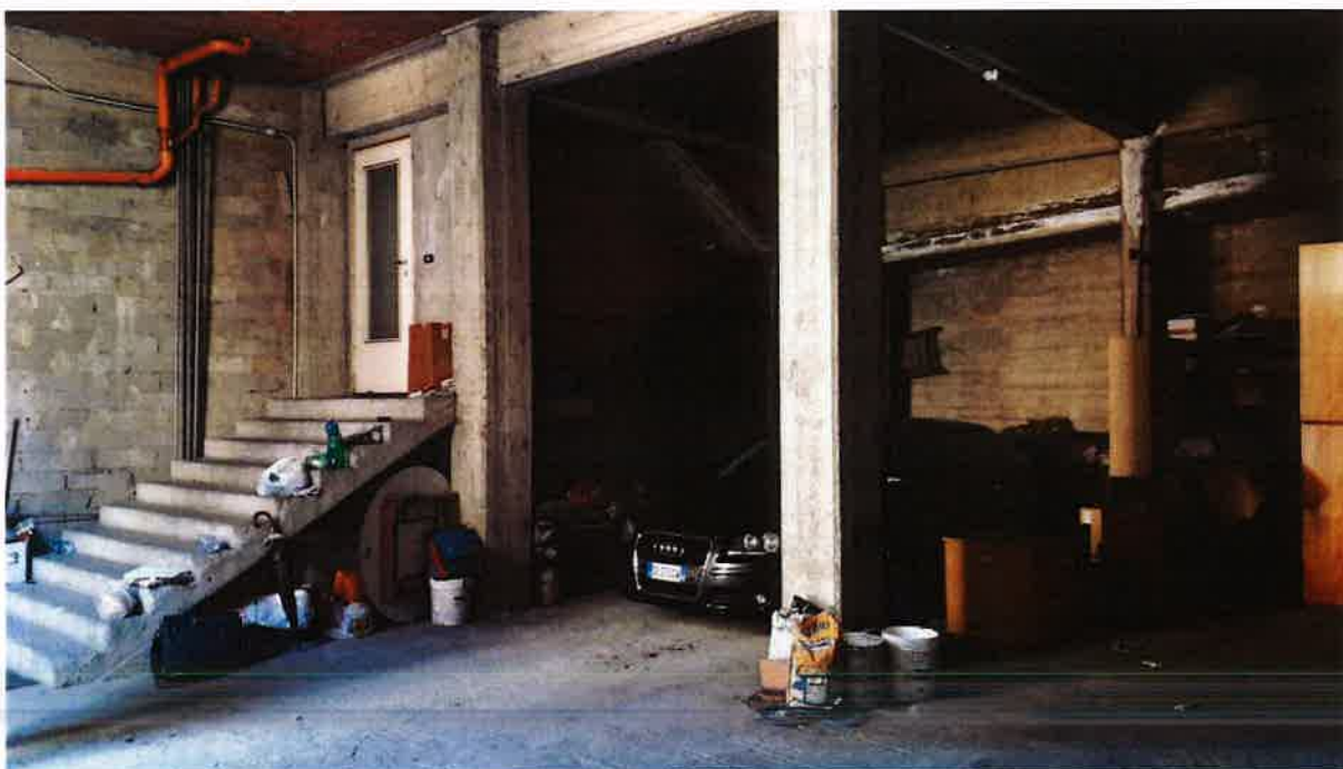
Foto 4 – Vista interna autorimessa (E)
