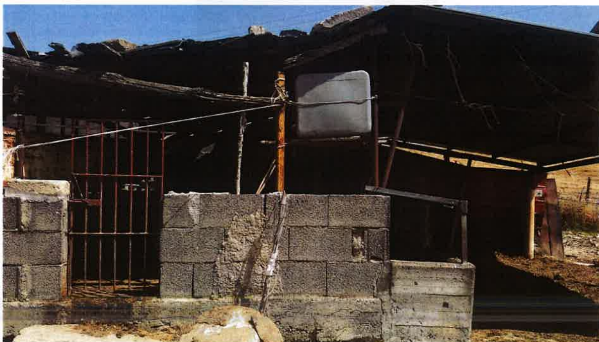
Foto 34 – Vista ingresso stalla porcilaia e tettoia non censite, contrada Lavanche
