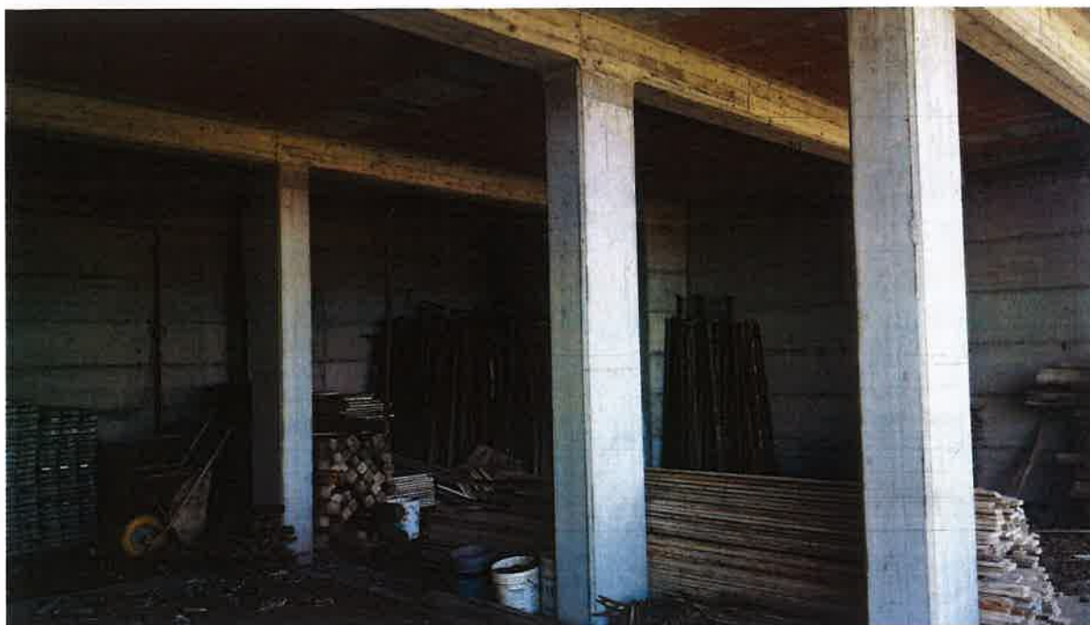
Foto 5 – Vista interna fabbricato non censito terreno (D), fg. 26 part. 888, contrada Camatrona
