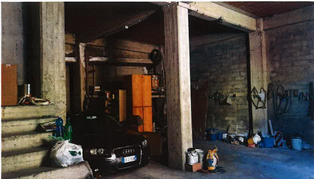
Foto 3 – Vista interna autorimessa (E)
