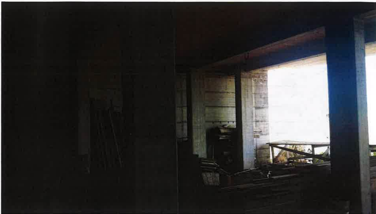
Foto 7 – Vista interna fabbricato non censito terreno (D), fg. 26 part. 888, contrada Camatrona
