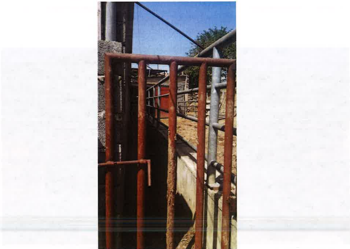
Foto 36 – Particolare esterno accanto ingresso stalla piccola (A4) contrada Lavanche
