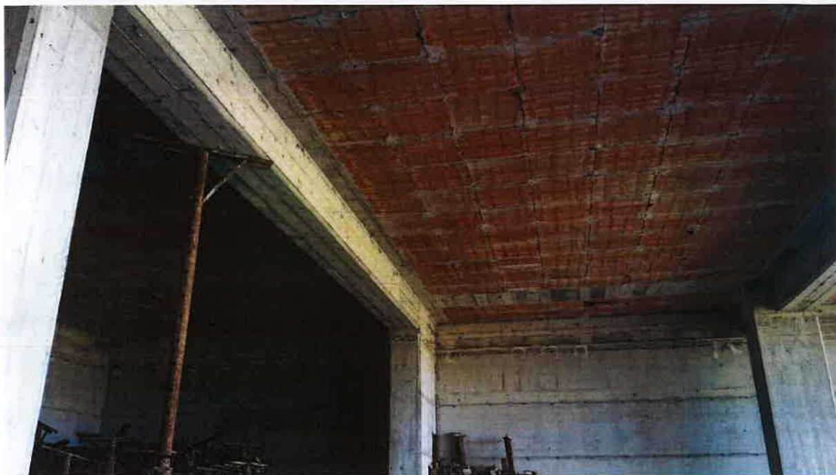
Foto 9 – Vista interna solaio fabbricato non censito terreno (D), fig. 26 part. 888, contrada Camatrona
