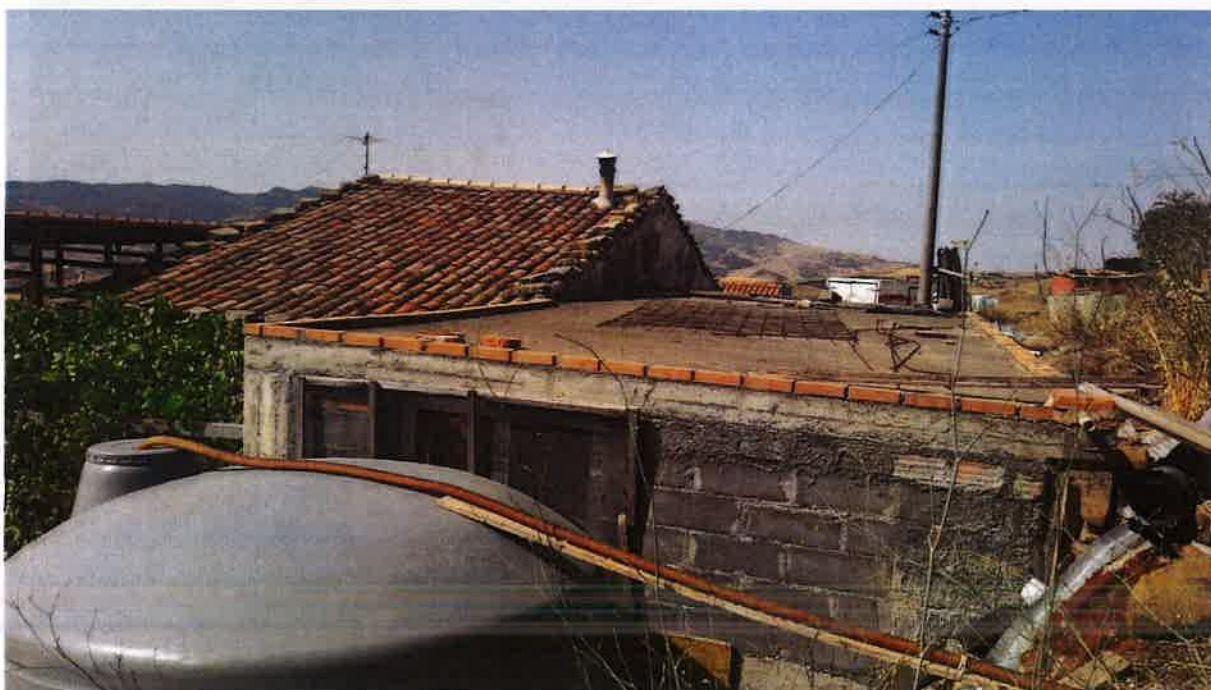
Foto 18 – Copertura laboratorio (A2) contrada Lavanche
