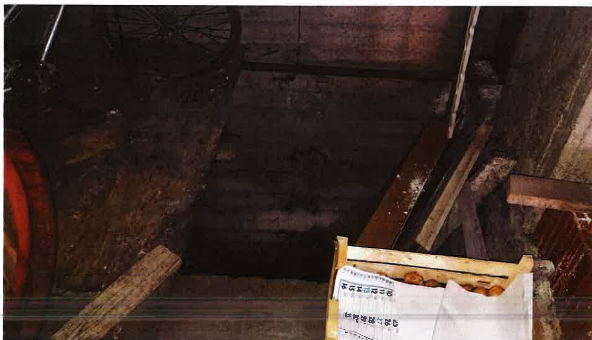
Foto 6 – Vista interna, particolare ingresso al piano non censito autorimessa (E)
