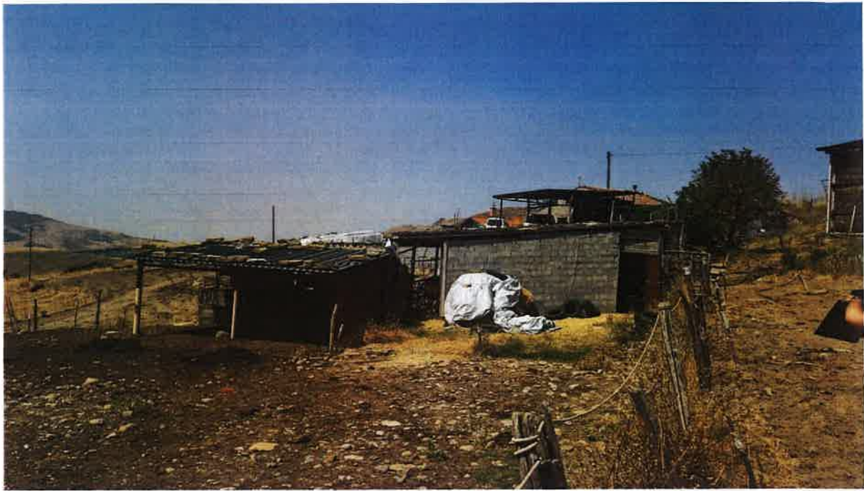
Foto 35 – Vista esterna tettoia non censita ed ingresso stalla piccola (A4) contrada Lavanche
