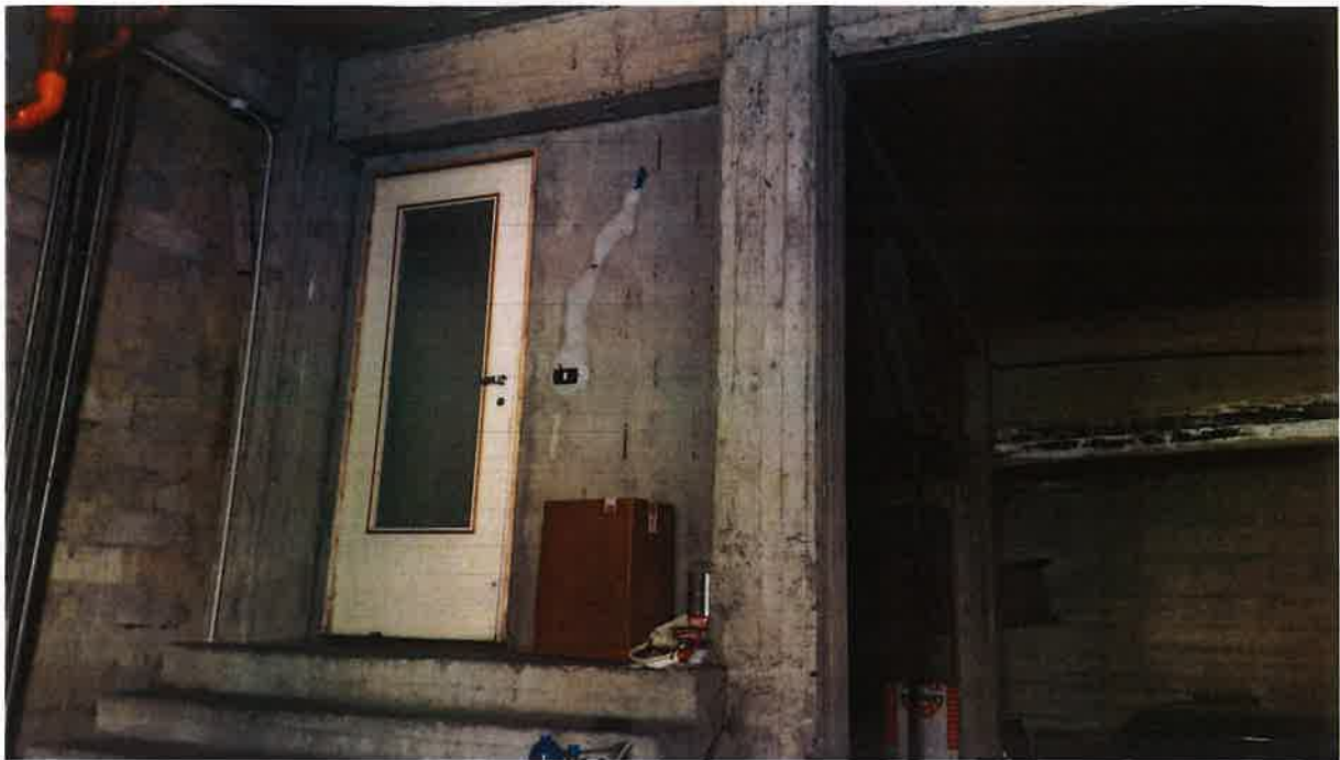
Foto 9 – Vista interna, particolare ingresso vano scala condominiale autorimessa (E)
