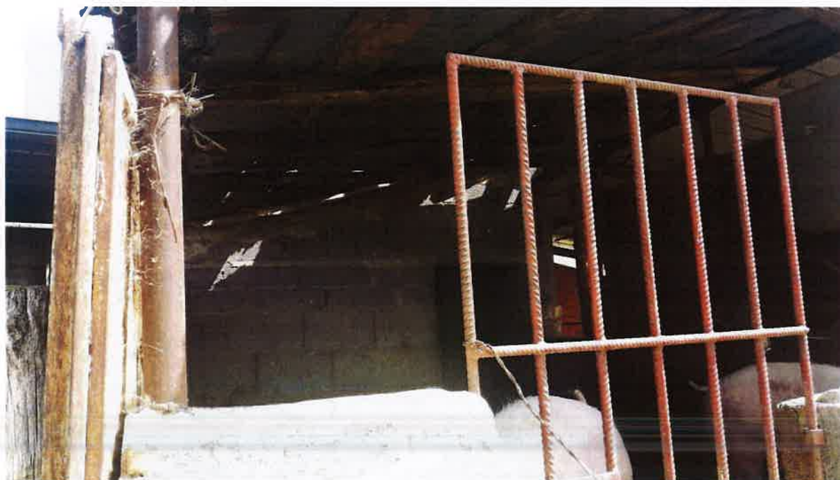
Foto 30 – Vista esterna stalla porcilaia non censita, contrada Lavanche
