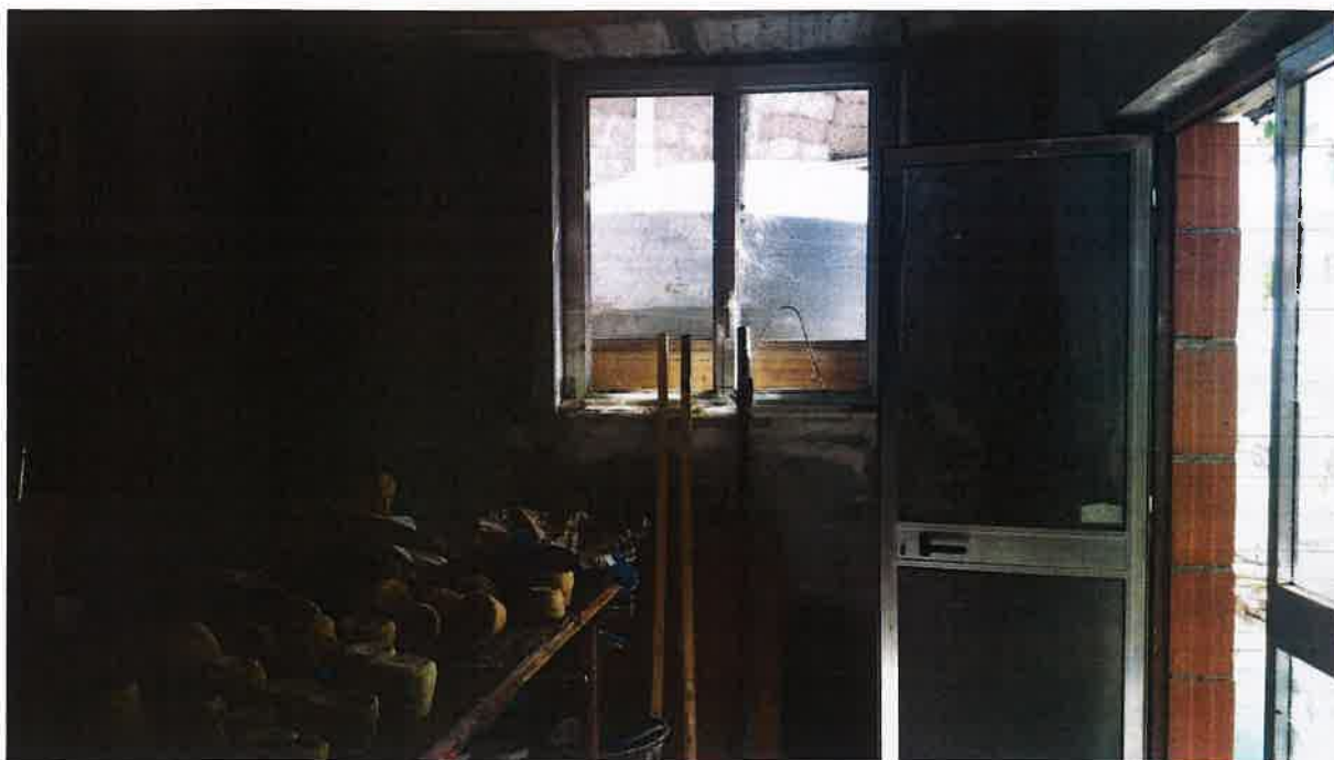
Foto 17 – Infissi laboratorio (A2) contrada Lavanche
