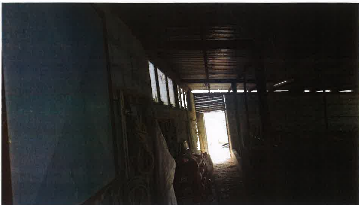
Foto 25 – Vista interna stalla piccola (A4), contrada Lavanche
