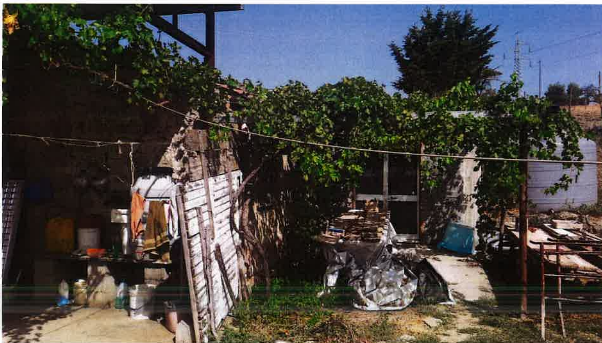
Foto 10 – Prospetto ingresso laboratorio (A2) contrada Lavanche
