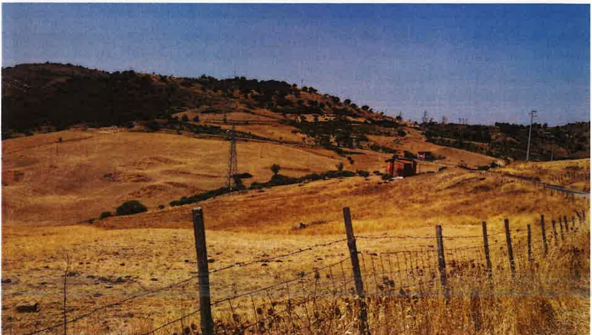
Foto 2 – Vista dall'alto del terreno (B1) fg.14 part. 142, contrada Serro Croce
