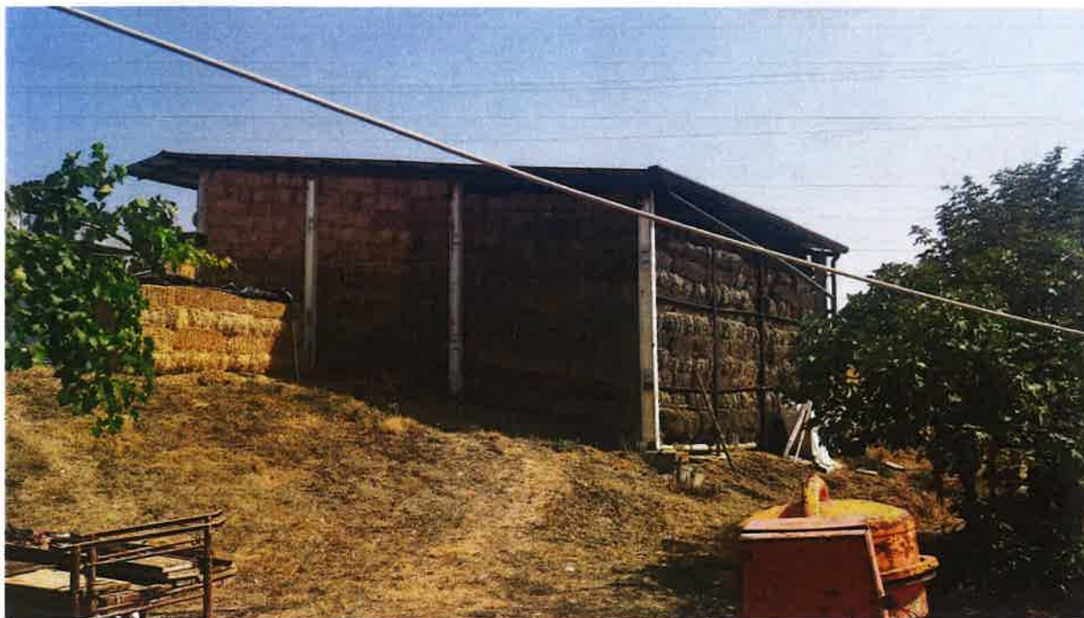
Foto 37 – Vista esterna fienile (A5) contrada Lavanche
