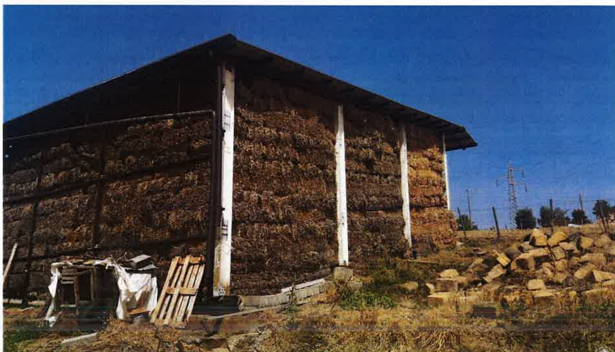
Foto 38 – Vista esterna fienile (A5) contrada Lavanche
