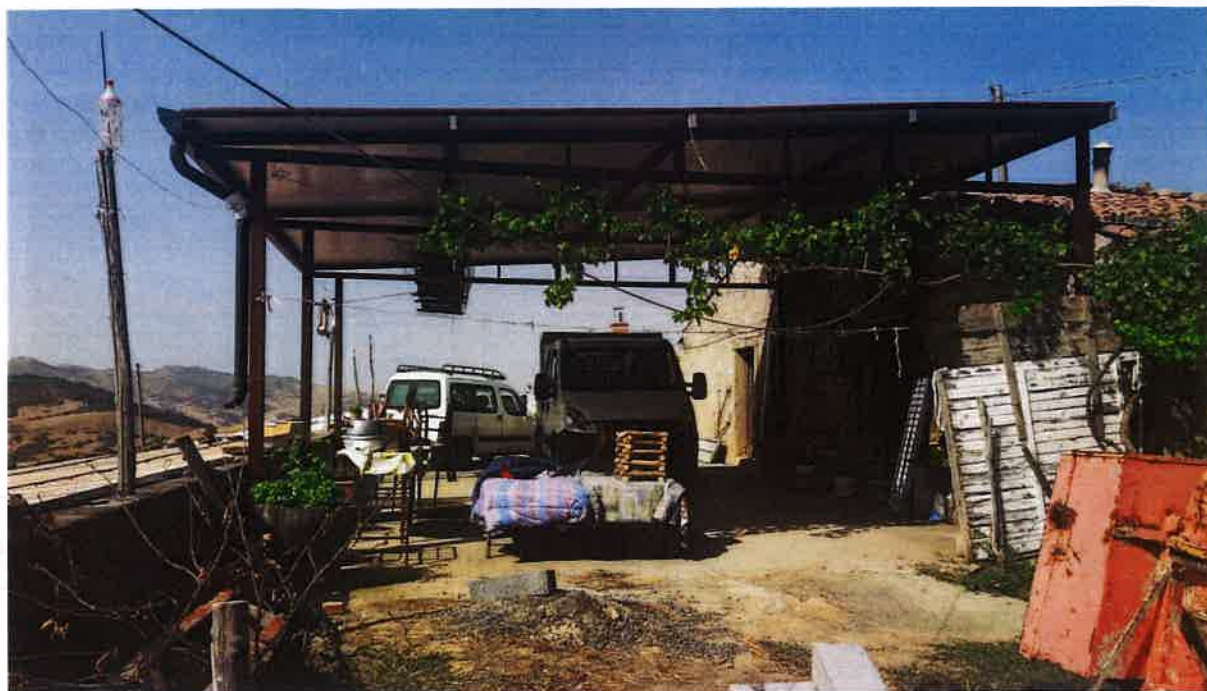
Foto 3 – Tettoia prospiciente abitazione (A1) contrada Lavanche
