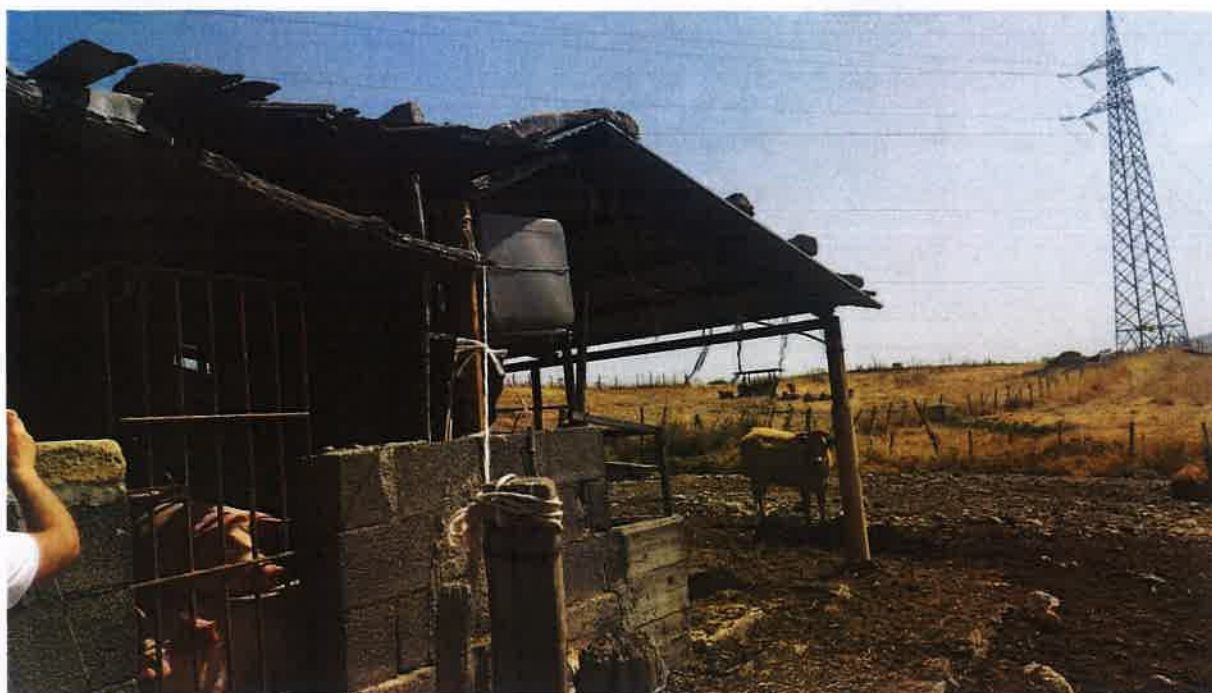
Foto 29 – Vista esterna stalla porcilaia e tettoia non censite, contrada Lavanche
