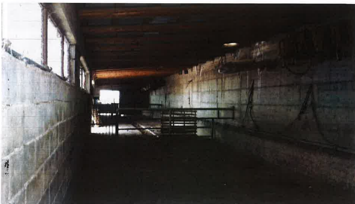
Foto 21 – Vista interna stalla grande (A3) contrada Lavanche, lato del debitore esecutato
