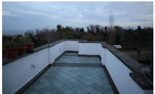
Viste esterne dell'unità di cui al sub. 104
