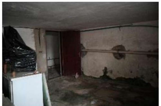
Viste interne dell'unità di cui al sub. 2
