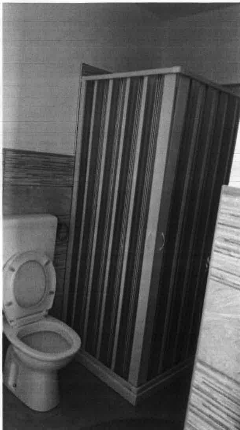
Foto 13 – Vista interna bagno (A8) contrada Lavanche
