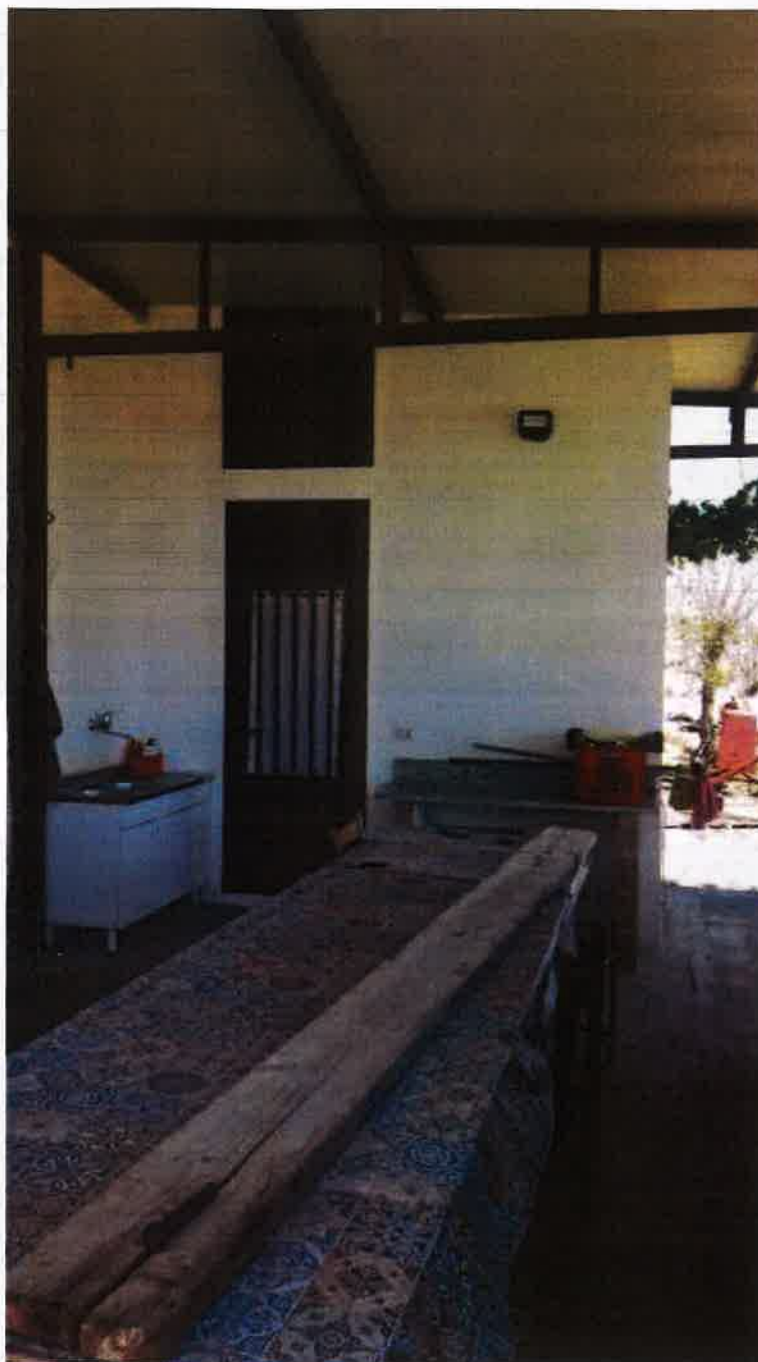
Foto 3 – Ingresso bagno (A8) contrada Lavanche
