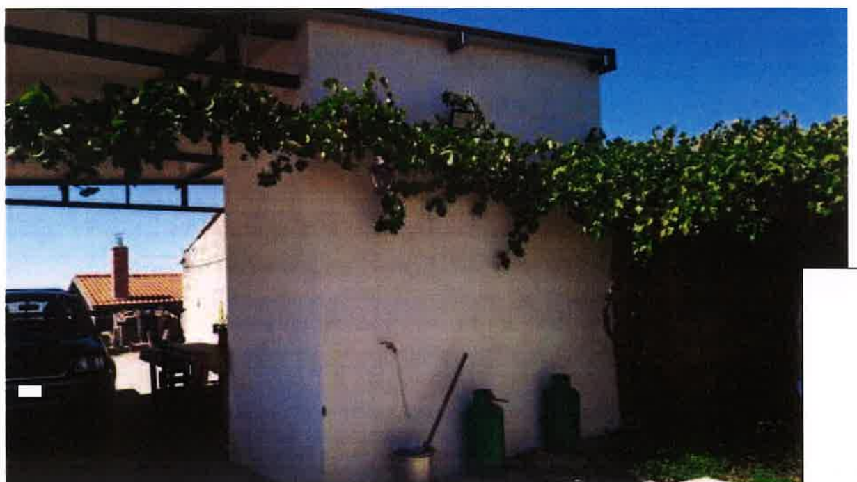
Foto 2 – Prospetto posteriore bagno (A8) contrada Lavanche
