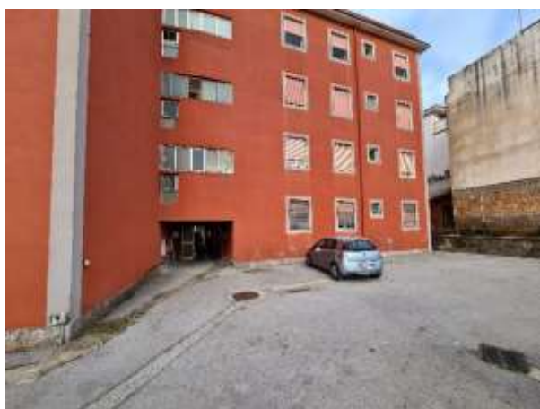
Ingresso area condominiale
