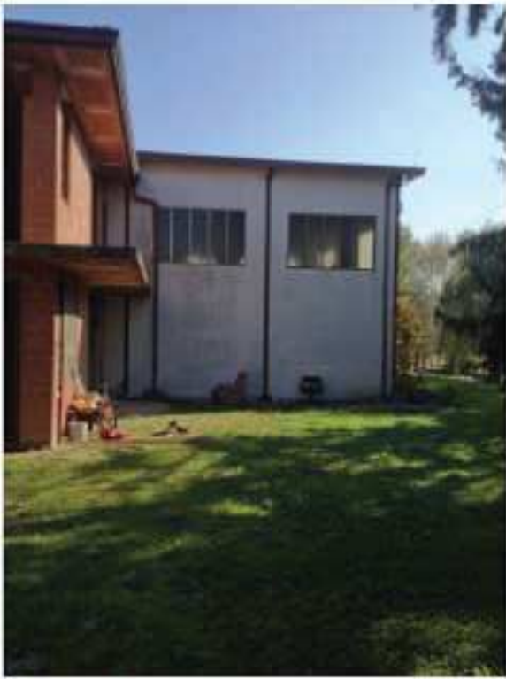
LOTTO 1 - Esterno sud 1
