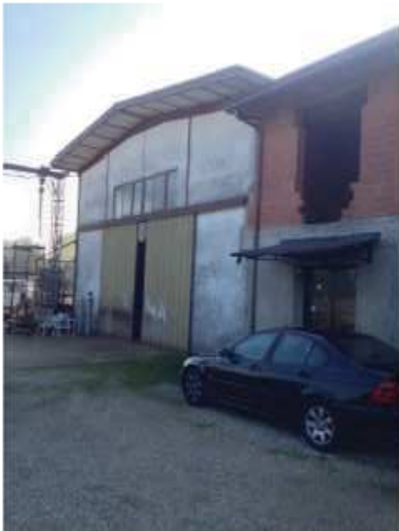
LOTTO 2 - Capannone e ingresso uffici
