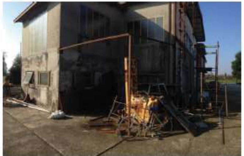
LOTTO 2 - Capannone Nord/Est
