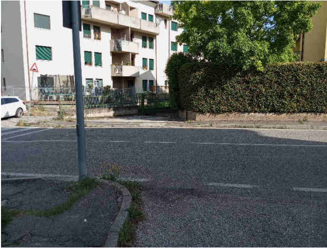
ingresso carraio ai garage
