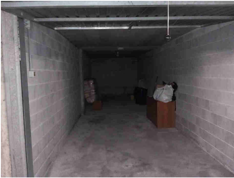
interno del garage
